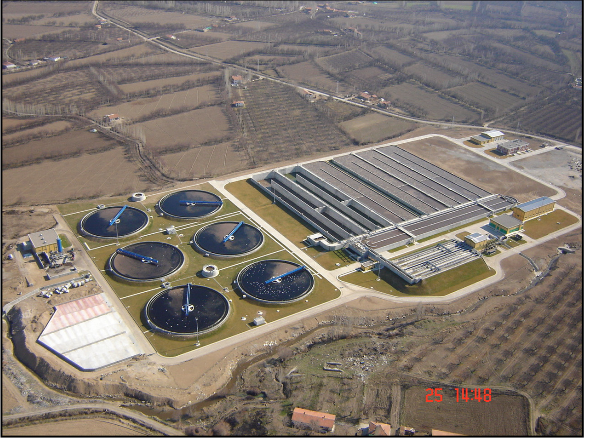
Şekil 1.2 Arıtma Tesisi Fotoğrafi
