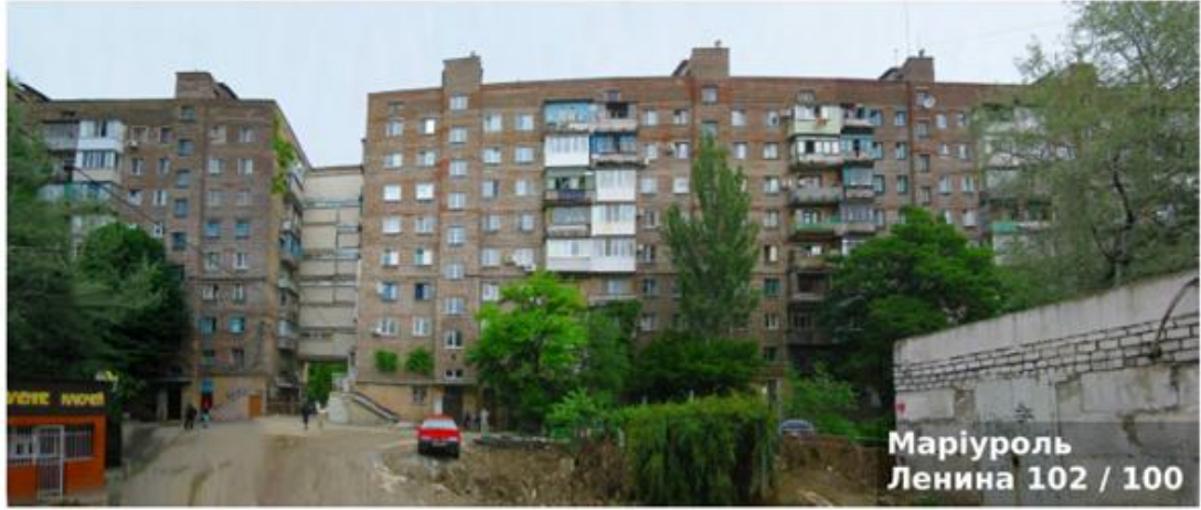
Şekil 2.5. Ukrayna'da geopolimer beton kullanılarak üretilmiş konut yapıları (Hlavacek, 2014)
