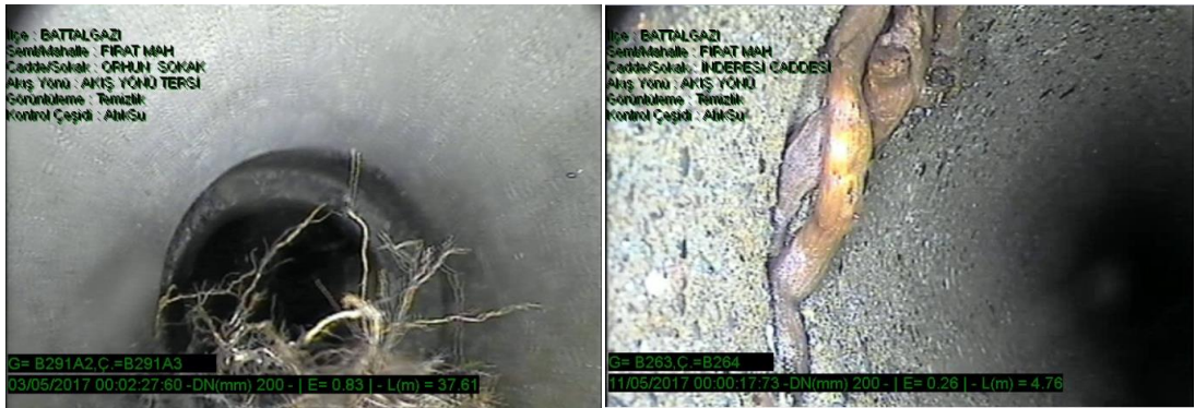
Şekil 4.9. Yapısal Kusurlar, Ağaç ve Bitki Kökleri (MASKİ, 2018)
