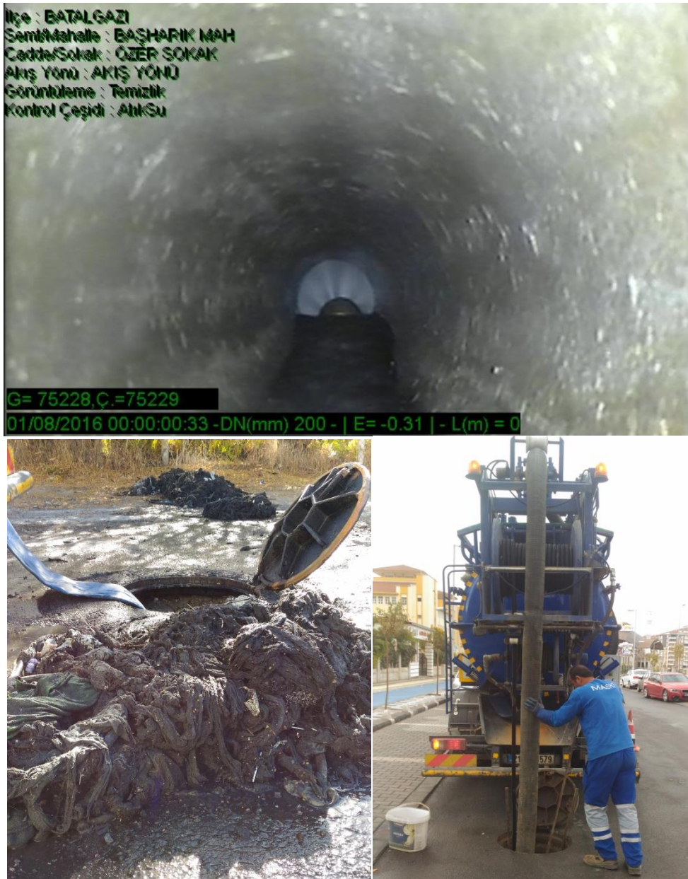
Şekil 4.3. Kombine Aracı ve Vidanjör ile Kanal Temizliği (MASKİ,2018)
