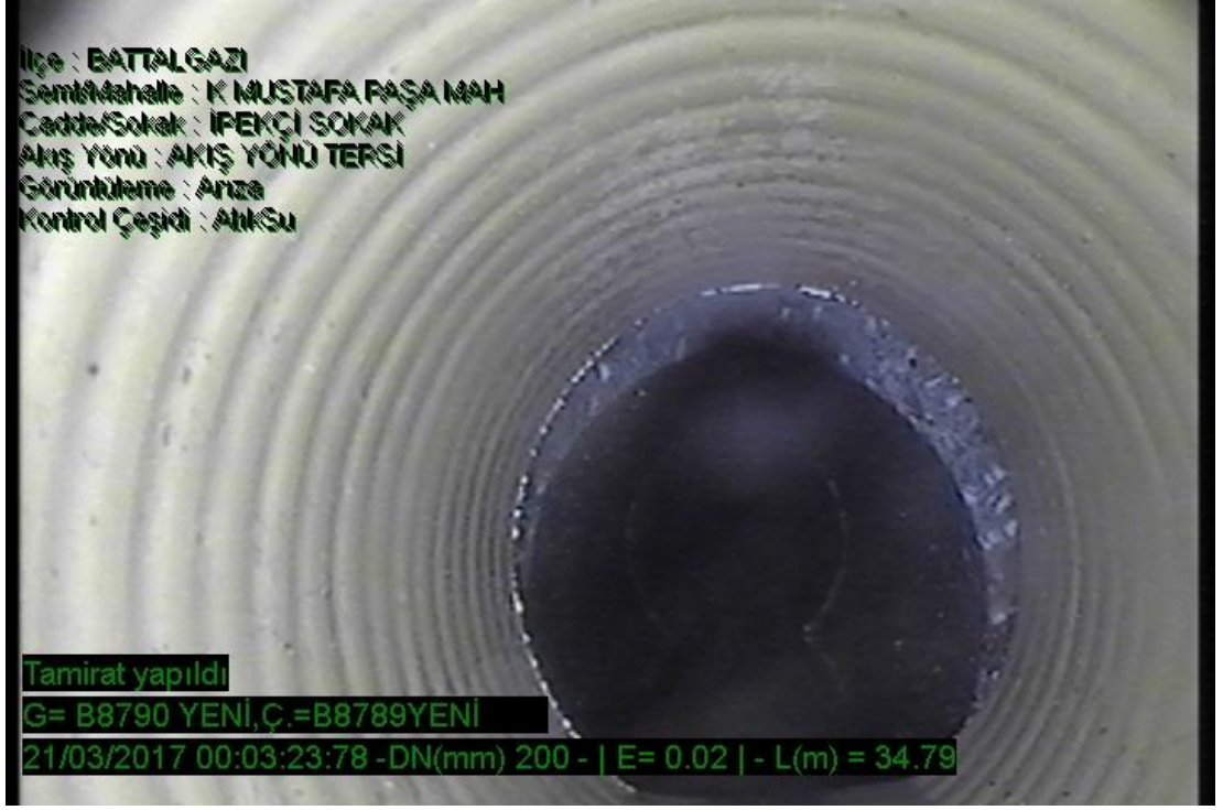
Şekil 4.14. Yapısal Kusurlar, Noktasal Tamir Oranı (MASKİ, 2018)
