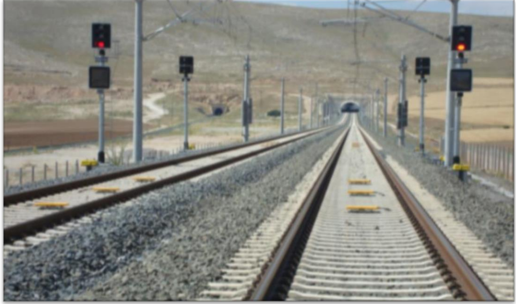
Şekil 2. 7. Demiryolu güzergahında balastın konumu
