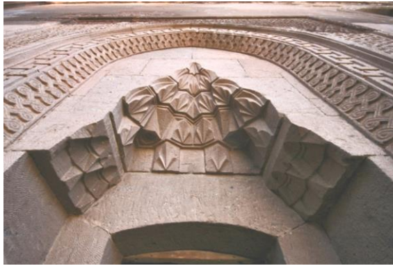
Resim 2.5: Karatay Han, Kayseri'nin Bünyan ilçesine bağlı Karadayı köyünde bulunan Kervansaray, Kayseri-Malatya Karayolu'nun üzerinde ve Kayseri'ye 45 km uzaklıktadır. Selçuklu Veziri Celaleddin Karatay tarafından, 1240 yılında yaptırılmıştır.
