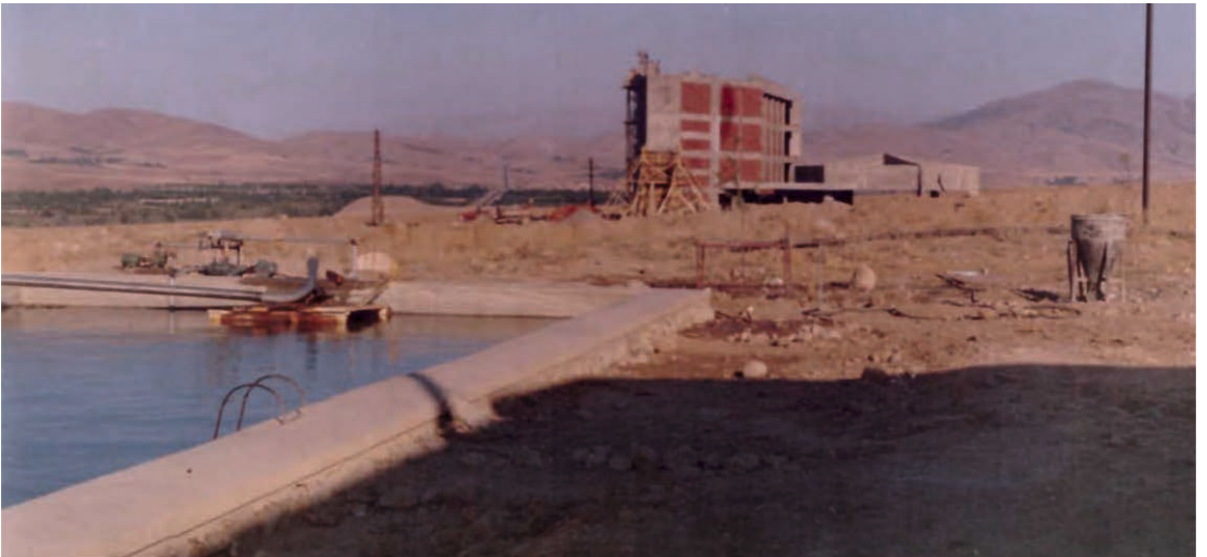
Kampüs Fen-Edebiyat Fakültesi Derslikleri İnşaatı
