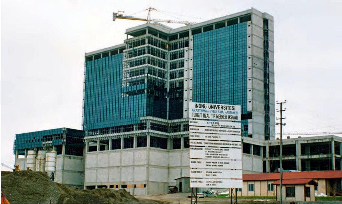
İnönü Üniversitesi Turgut Özal Tıp Merkezi İnşaatı (Hamle Gazetesi Arşivi)
