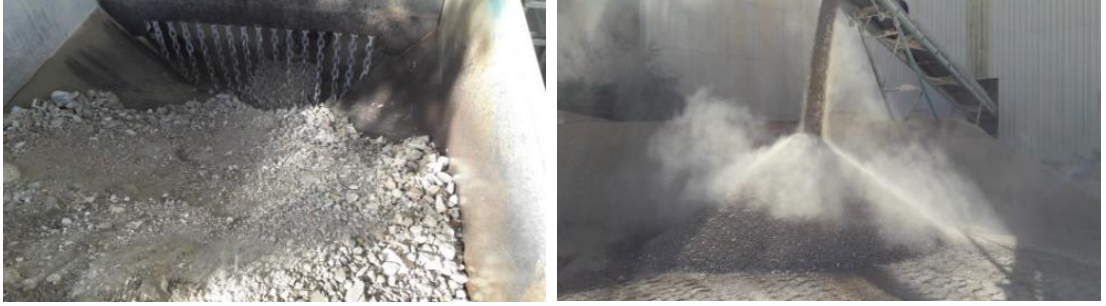
Şekil 3.3. Molozların konkasöre yüklenmesi ve kırılması işlemi (Ok ve Demir, 2018)
