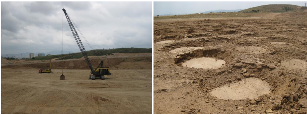
Şekil 2.16. Dinamik kompaksiyon uygulaması (Anonim, 2019g)
