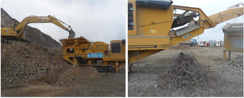
Şekil 2.8. CDW'nin eleğe alınması (solda) ve CDW'den demirin ayrıştırılması (Karaca, 2012)
