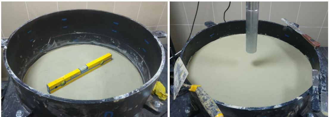
Şekil 3.72. Sıkıştırma işlemi tamamlandıktan sonra kohezyonlu zemin yüzeyinin düzgünlüğünün kontrol edilmesi
