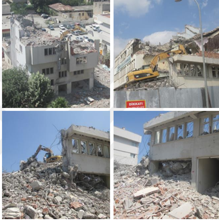
Şekil 3.2. İl özel idaresi binasının yıkılması işlemi (Ok ve Demir, 2018)
