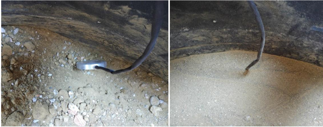
Şekil 3.76. Basınç ölçerin dolgu içerisine yerleştirilmesi
