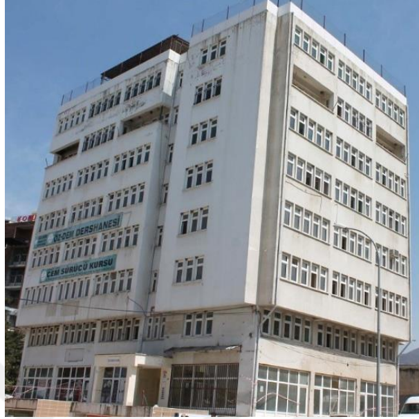
Şekil 3.1. Osmaniye ili Düziçi ilçesinde bulunan İl Özel İdaresi Binası'nın yıkılmadan önceki hali (Ok ve Demir, 2018)
