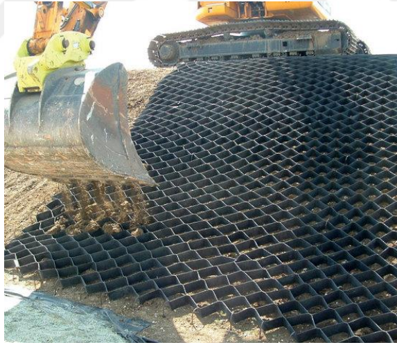
Şekil 2.29. Geocell'in uygulama örneği (Anonim, 2019o)
