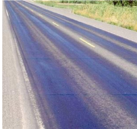
Şekil 2.21 : Asfaltta Kusma [48].
