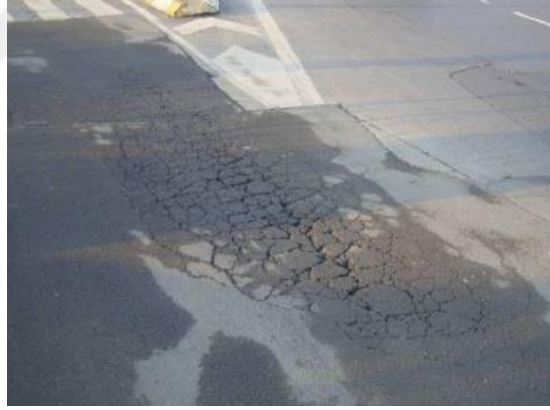
Şekil 2.19 : Yorulma Çatlağı [48].
