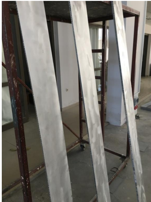
Şekil 3.11. Yapıştırılmaya hazır paneller
