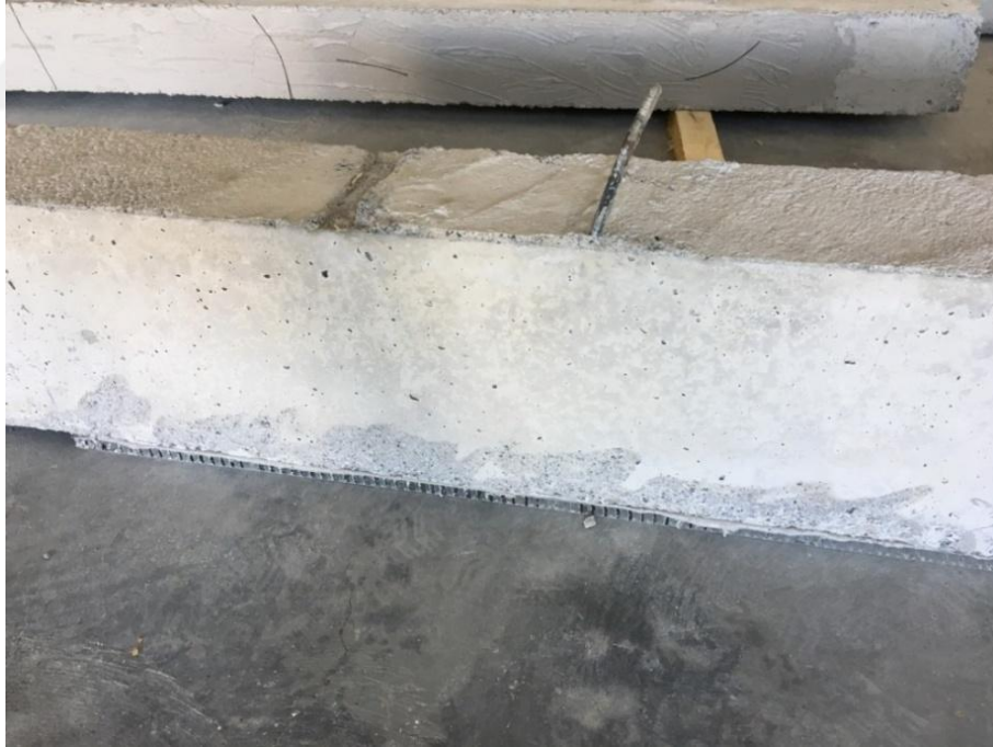
Şekil 3.16. Kirişin ters çevrilerek panelin sıkıştırılması
