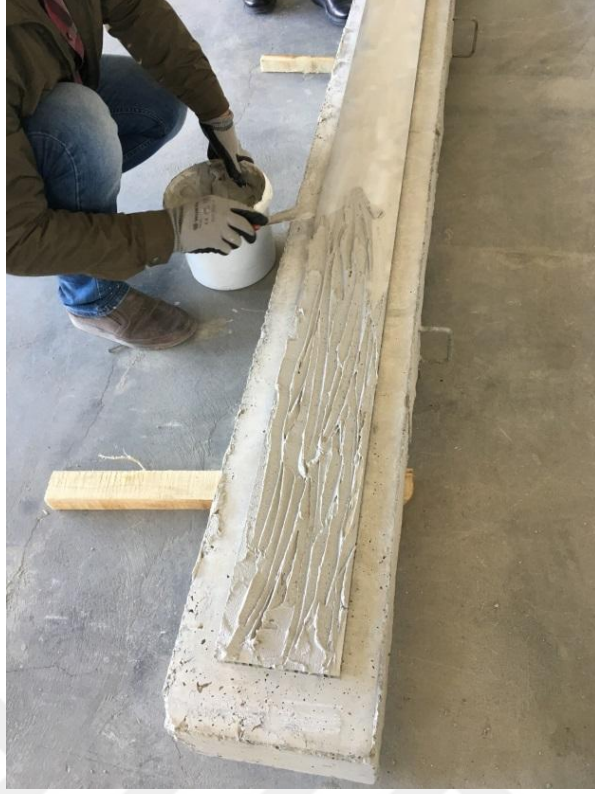
Şekil 3.15. Yapıştırıcının panel üzerine uygulaması
