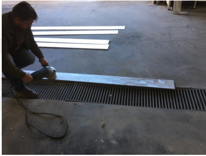
Şekil 3.10. Panel yüzeyinin temizlenmesi
