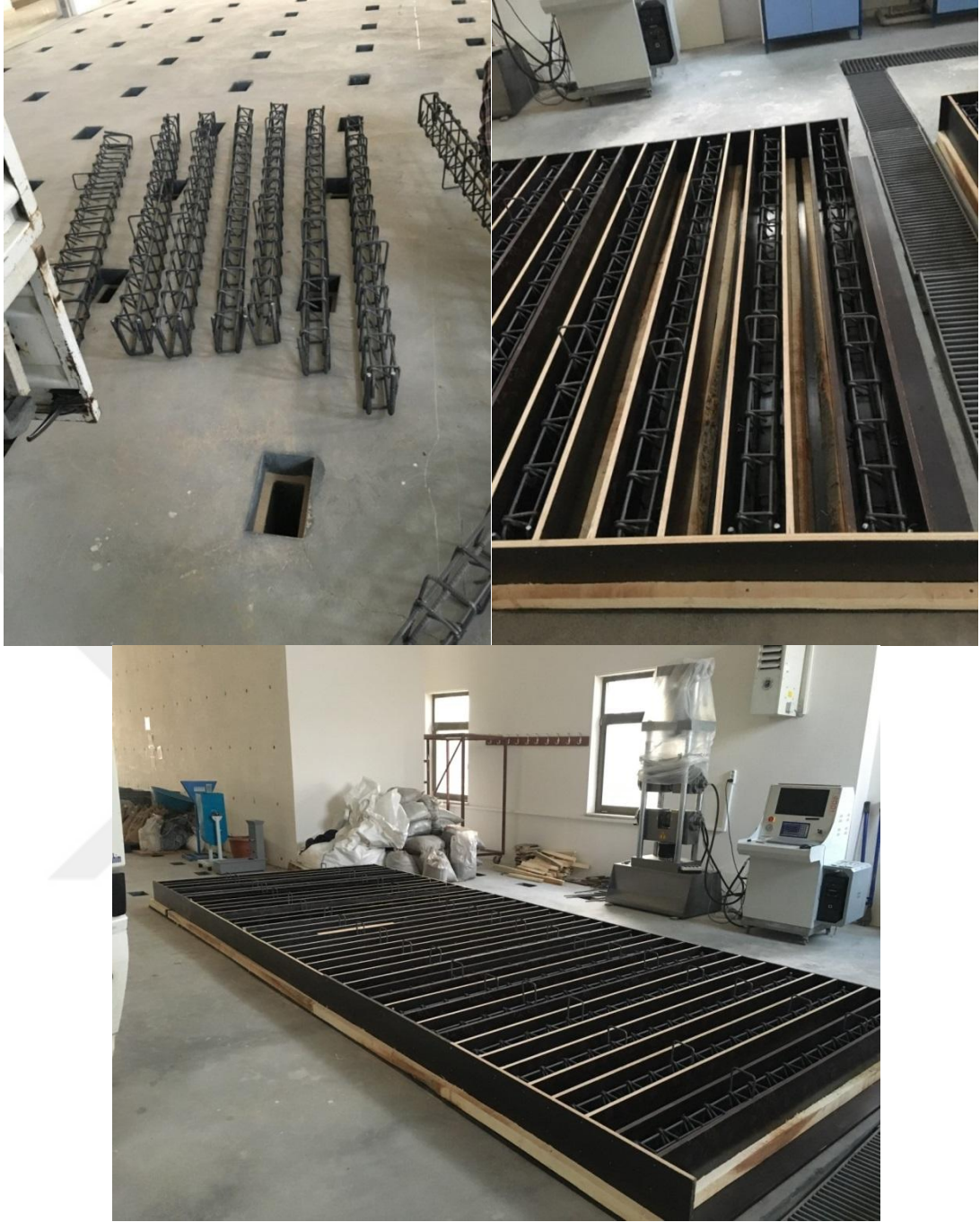
Şekil 3.7. Donatı hazırlanması
