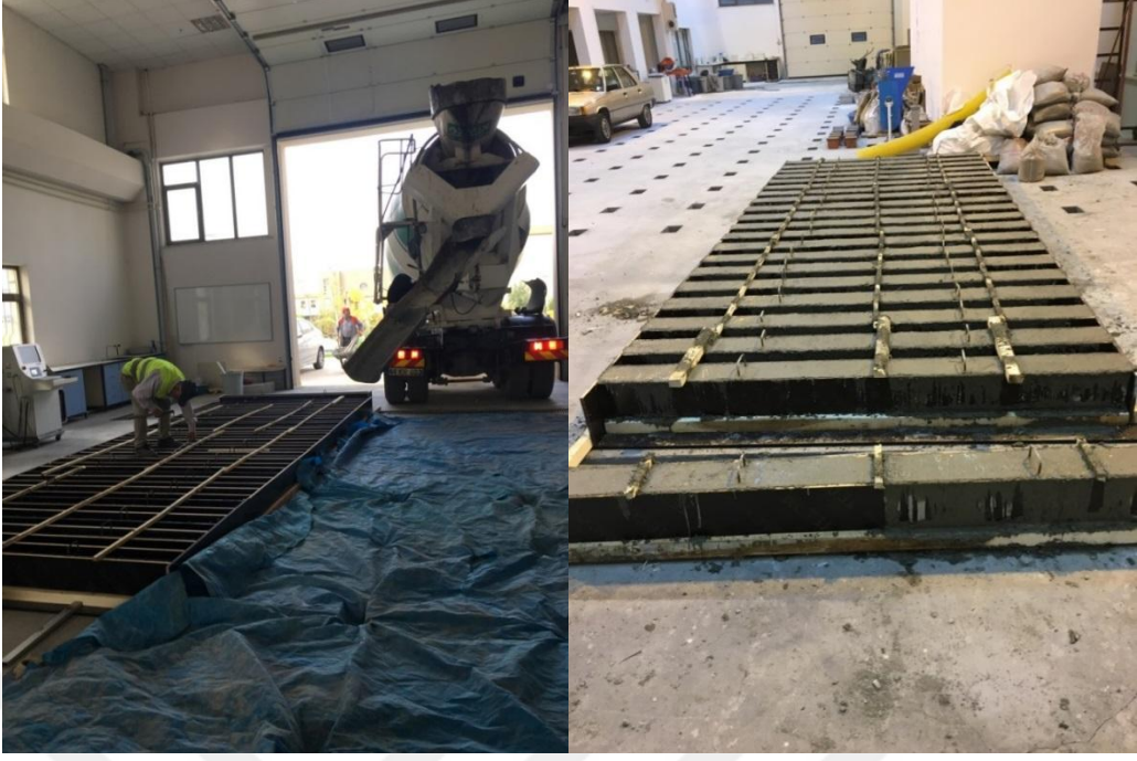
Şekil 3.8. Beton dökümü
