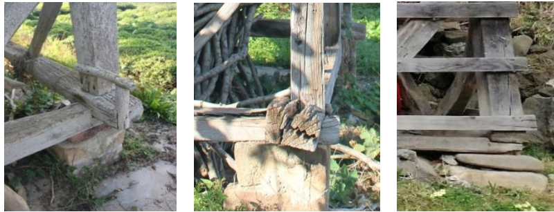
Şekil 7. Serenderin zeminle bağlantısı
