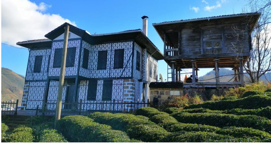
Şekil 1. Serender konut ilişkisi, Sürmene-Aksu Mahallesi/Trabzon
