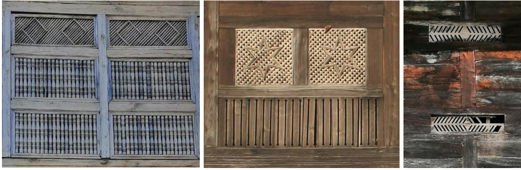
Şekil 14. Serender havalandırma ve süsleme detayı örnekleri
