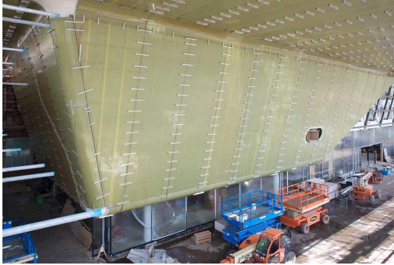
Şekil 10- Karbon ve aramid elyaf kombinasyonu kullanılarak üretilen fiber malzeme ile üretilen yüzeyler (URL-8).
