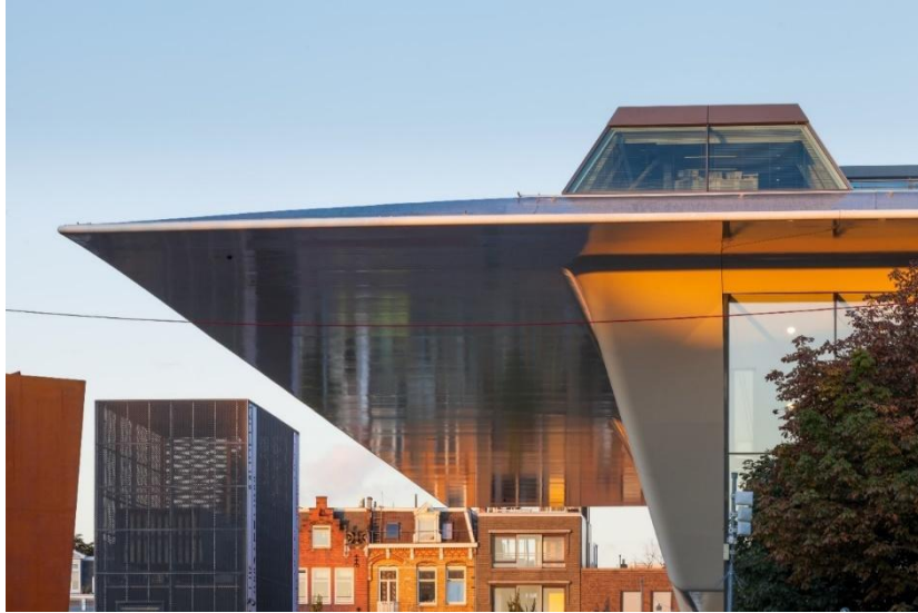
Şekil 11- Sıcaklık farkında en iyi ısıl genişleme performansını verecek, kesintisiz ve ek yeri olmayan yüzeyler oluşturulmuştur (URL-5).
