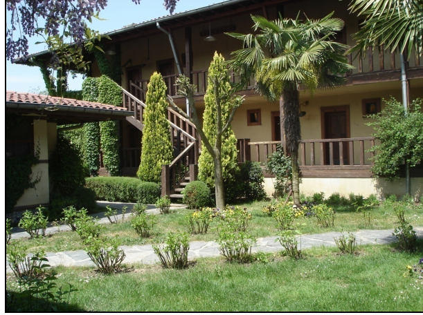
Şekil 14. Kerpiçten yapılmış konaklama yapısı, Saklıköy Country Club, Beykoz, İstanbul.
