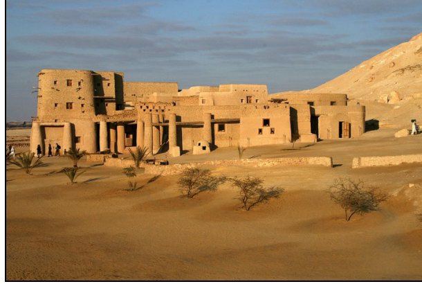
Şekil 3. Adrere Amellal Oteli seçilen malzeme ve doğaı çevre uyumu, Mısır (URL3, 2010).
