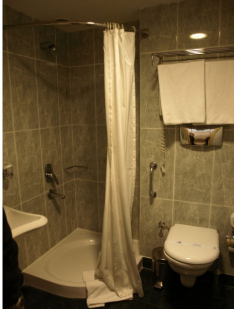
Şekil 5. Tekerlekli sandalye yanaşma mesafesi olmayan banyo ve yüksek duş, Porto Bello, Antalya, 2011
