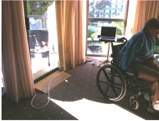
Şekil 4. Balkona çıkmak için tekerlekli sandalye kullanıcılarına uygun rampalar, Limak Artlantis Resort, Belek, 2011
