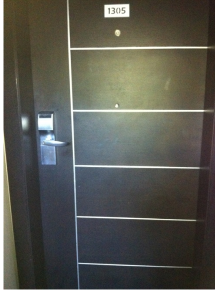
Şekil 1. Oda kapısı üzerindeki tekerlekli sandalye kullanıcılarına uygun yükseklikteki göz deliği, Limak Atlantis Resort, Belek, 2011
