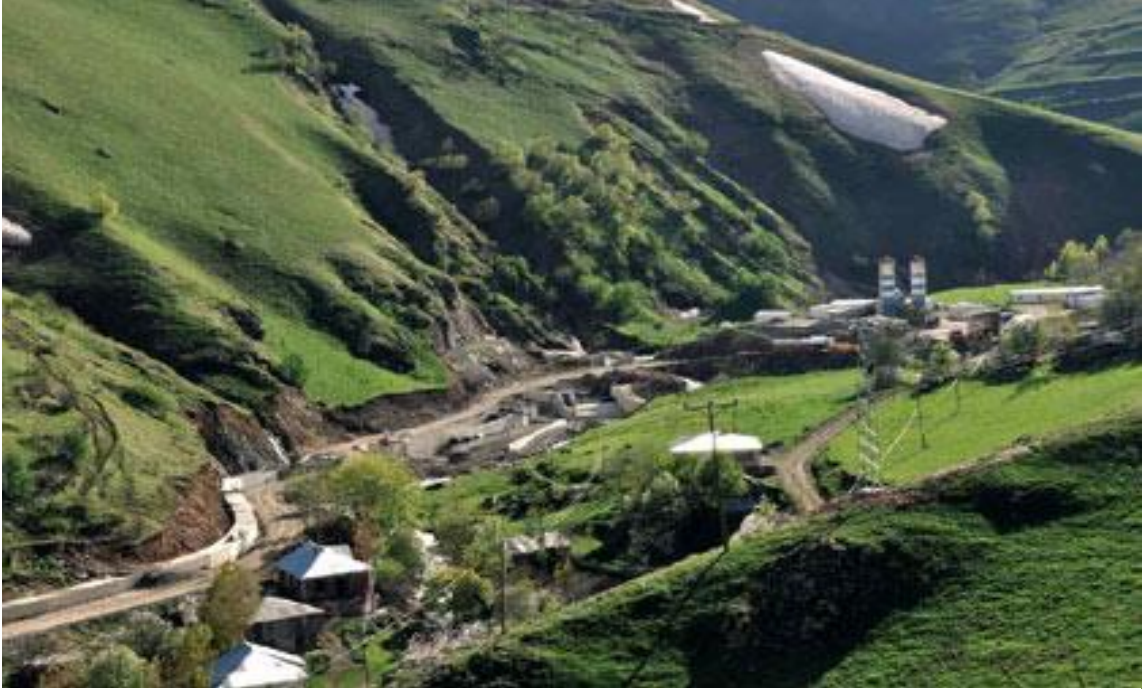
Resim 18: Bozkaya Barajı ve HES'inin yapılacağı bölge
