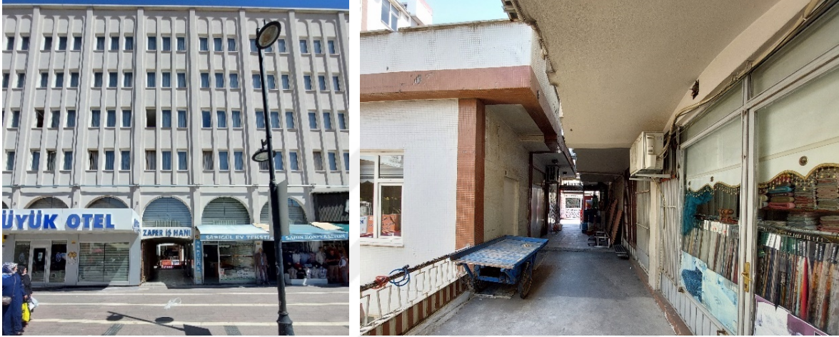
Şekil 4.21: Zafer İş Hanı ve yapı künyesi.
