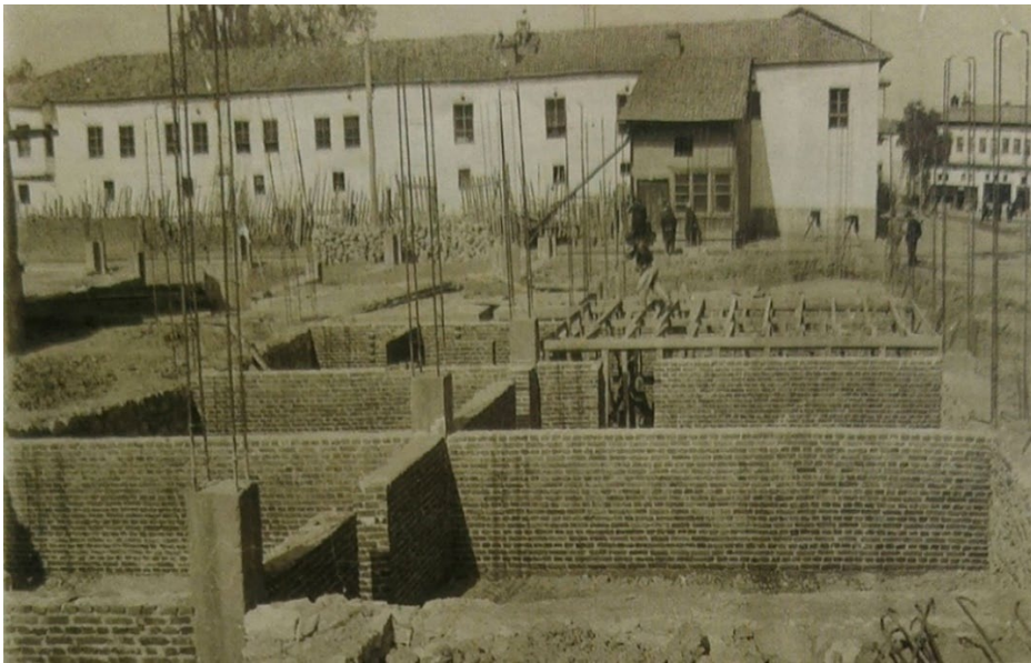
Şekil 3.8: Temelli Pasajı'nın inşaatı (1937) arkada Fırat İlköğretim Okulu.
