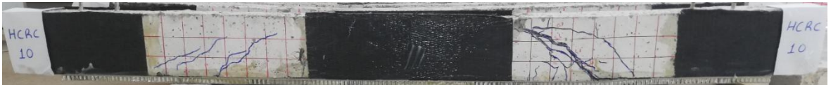
d) D Grubu (15 mm kalınlığa sahip bal peteği sandviç panel ile güçlendirilmiş betonarme kirişler, HCRC 8-10)
