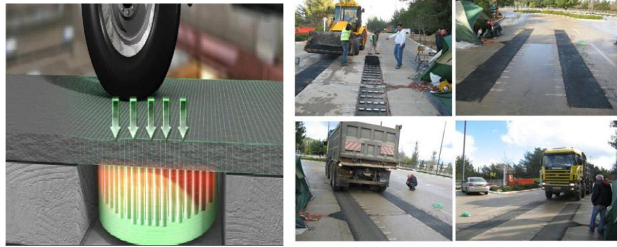
Şekil 2.3. Algılayıcı piezoelektrik malzemenin karayollarındaki uygulaması [6].
