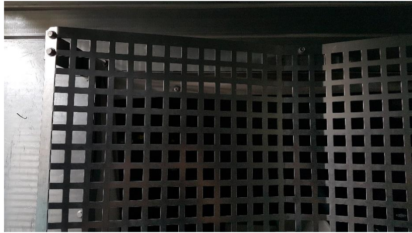
Şekil 3.5 Kare delikli difüzör
