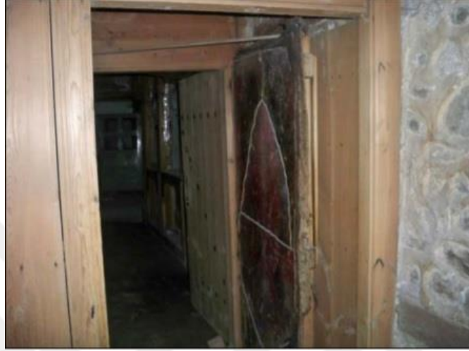
Şekil 2.41 Erzurum geleneksel konutlarına ait keçe ile kaplanmış kapı (Gök ve Kayserili, 2014).
