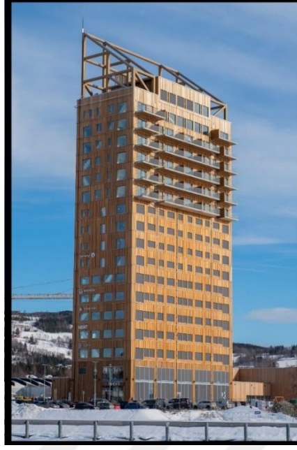
Şekil 2.9 2019 yılında Norveç’te CLT ve LVL malzemeyle üretilen dünyanın en yüksek ahşap yapısı (Dezeen, 2019).
