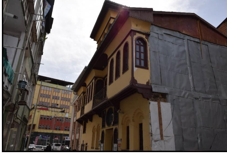
Şekil 4.38 İstanbulluoğlu Konağı Doğu cephesi (Orijinal, 2021).
