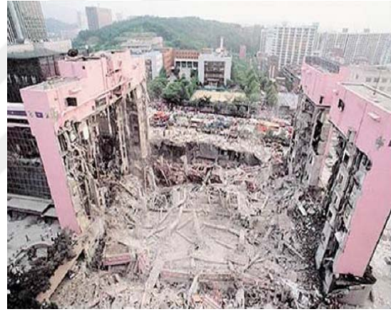
(b) Zımbalama göçmesi sonrası.
