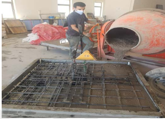
Şekil 3.17 : Büyük ölçekli döşeme-kolon birleşim elemanları için beton dökümü.
