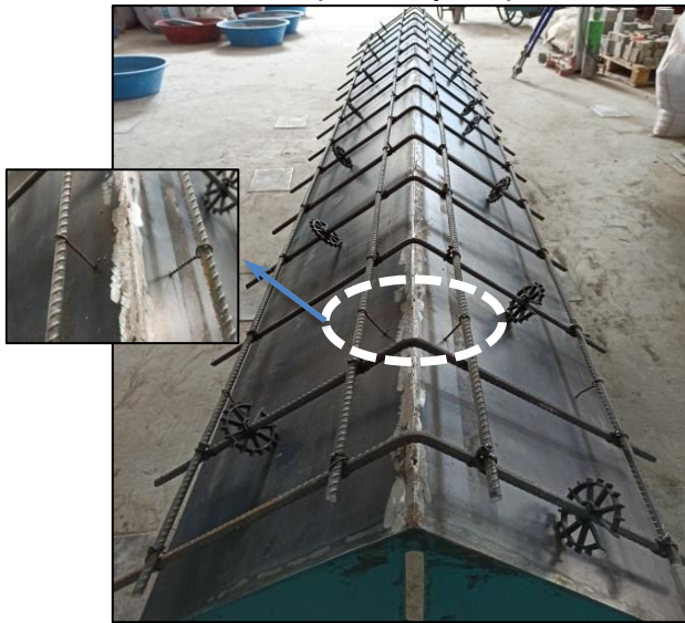
e) Donatıların beton dökümüne hazır hale gelmesi
