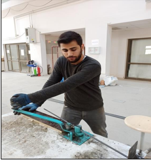
a) Enine donatıların bükülmesi
