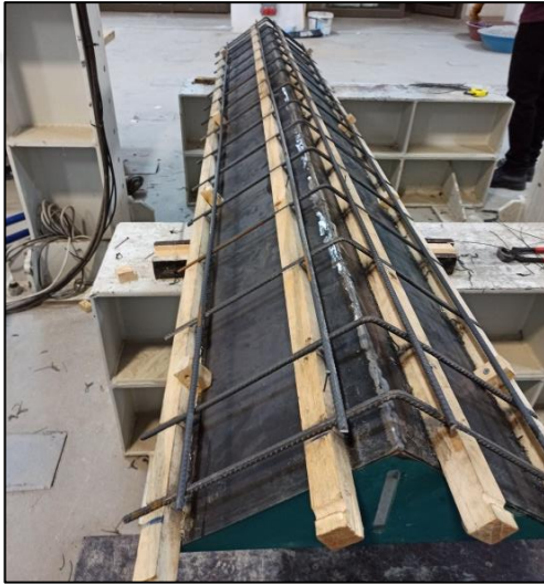
c) Donatıların şablona yerleştirilmesi
