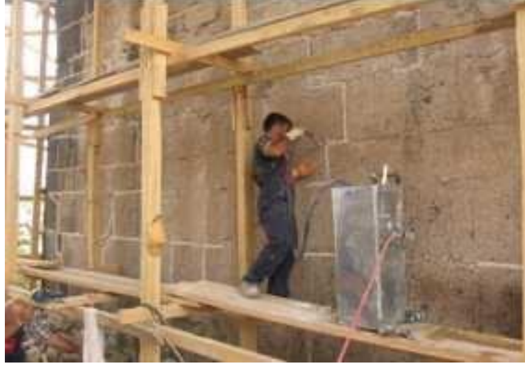
Şekil 2. 27: Cephe çatlaklarını onarmak için kireç bazlı malzemelerin kullanılması.
