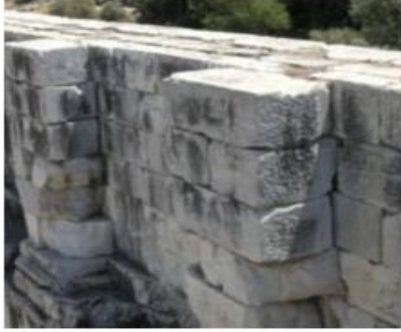
Taşın Taşıyıcı Malzeme Olarak Kullanımı (Didyma Antik Kenti - Apollon Tapınağı)
