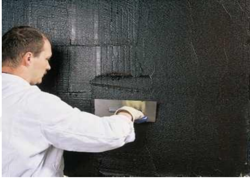
Şekil 2. 28: Su Yalıtımında bitüm duvar kaplamaları.
