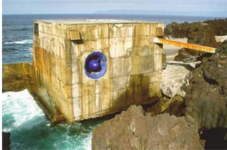
Şekil 3.2: Portekiz'in Azor Adaları'ndaki Pico adasındaki bir kıyı şeridi OWC dalga santrali [21]
