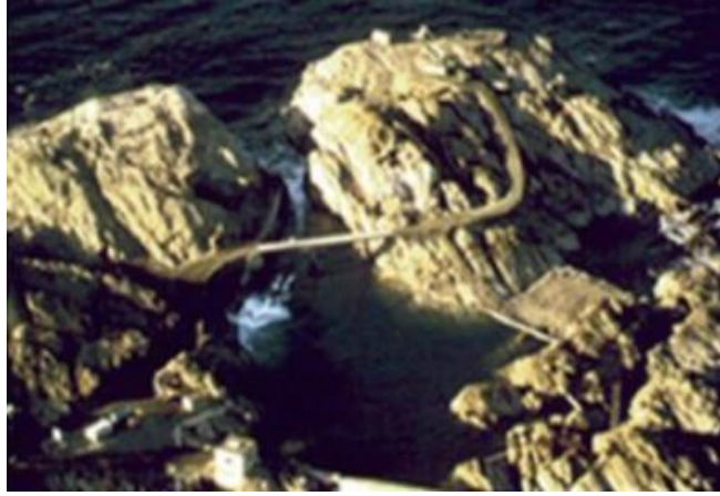
Şekil 3.5: Daralan Kanal (TAPCHAN) pilot tesis [24]
