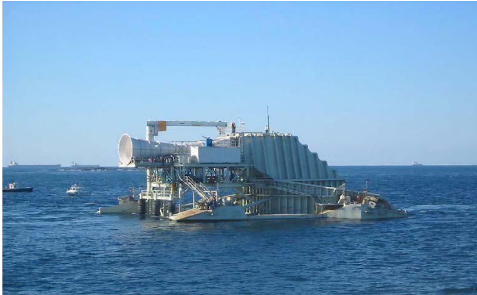
Şekil 3.9: Oceanlinx Dalga enerji dönüştürücüsü [28]
