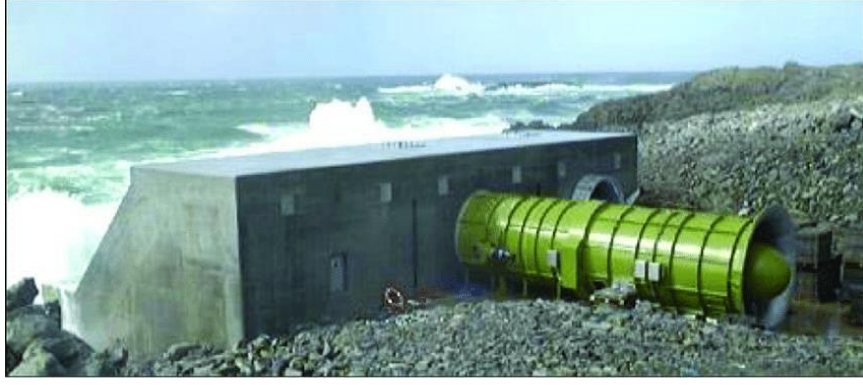
Şekil 3.3: 2000 yılında İskoçya, Birleşik Krallık'ta Islay adasında kurulan 500 kW gücündeki LIMPET OWC tesisi [22]
