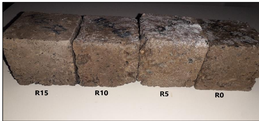
Şekil 4.19 : %5 Na 2 SO 4 çözeltisinde 12 hafta bekletilen numunelerin görünüşleri.
