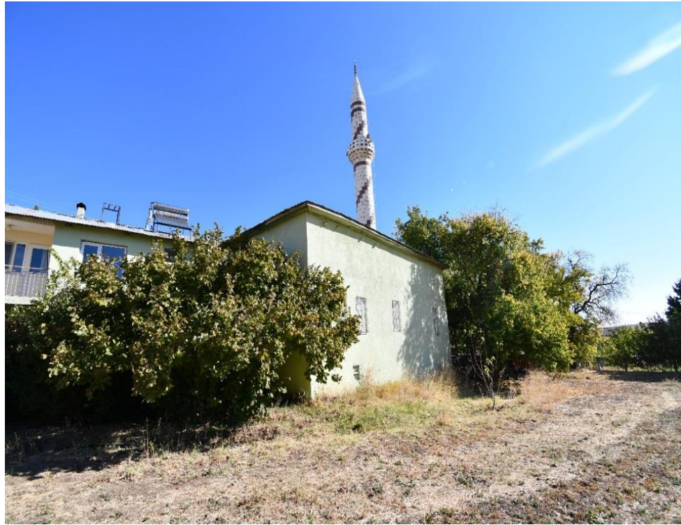
Fotoğraf 36: Cami güney cephesi
