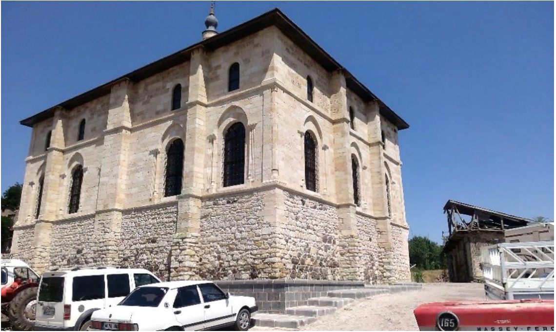
Fotoğraf 14: Cami güney ve doğu cephesi
