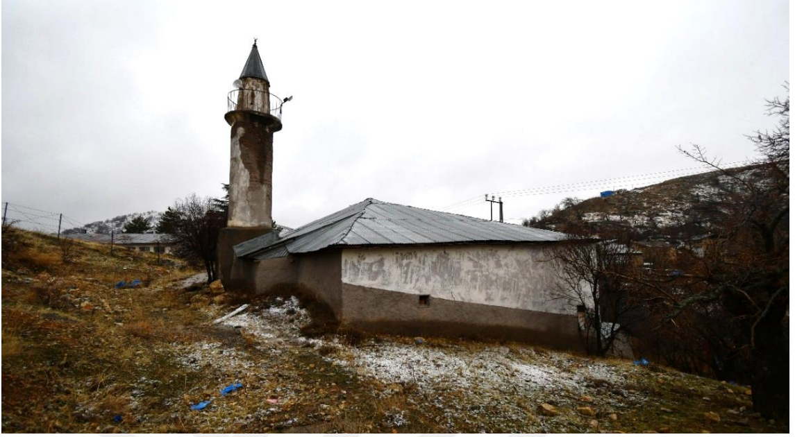
Fotoğraf 1: Cami kuzey cephesi ve minaresi
