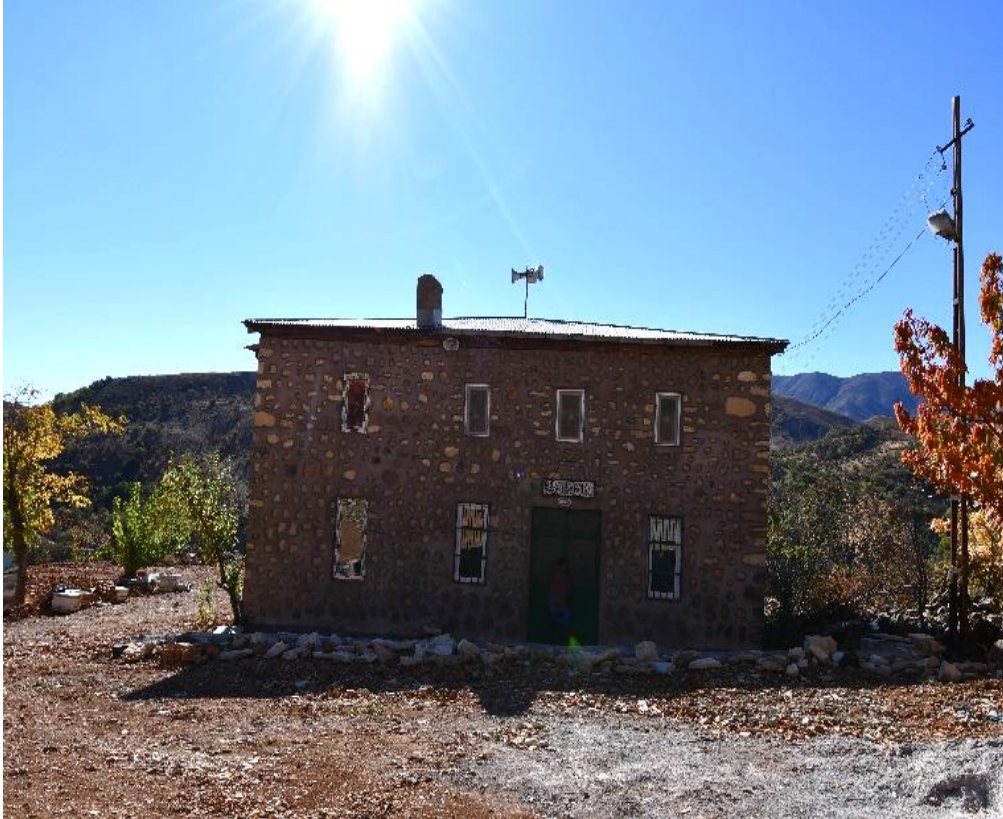
Fotoğraf 24: Cami kuzey cephe
