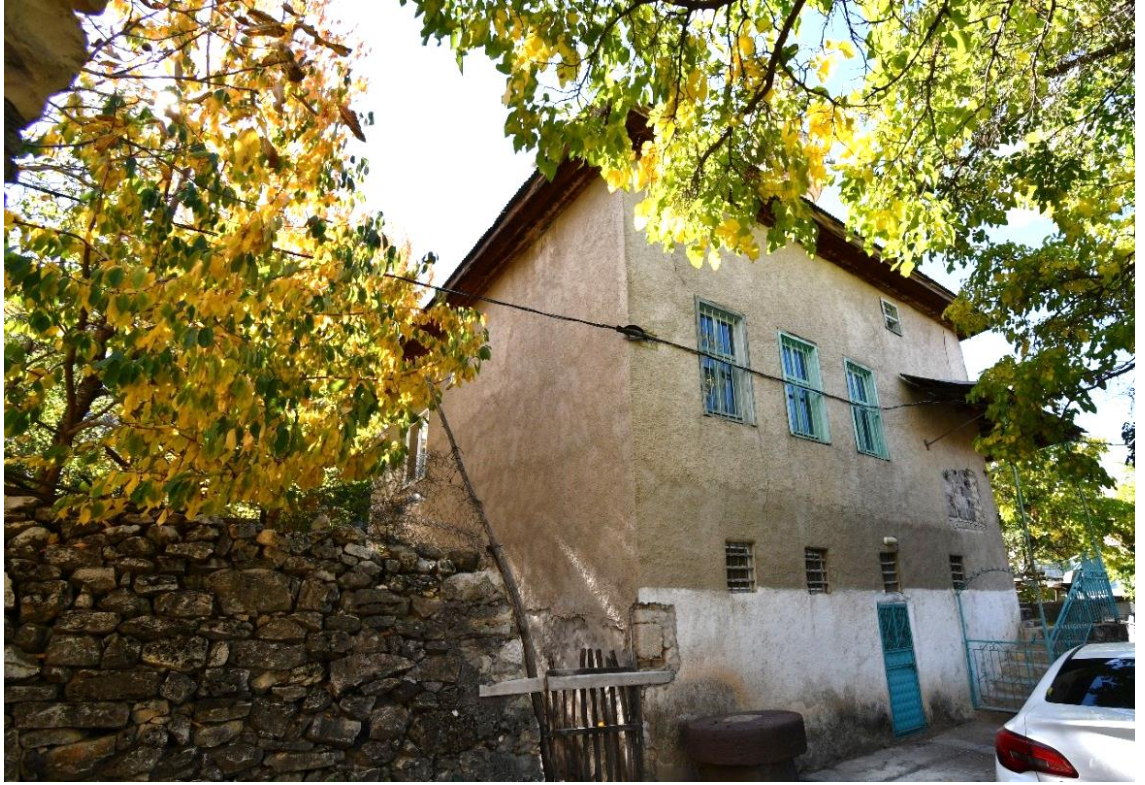
Fotoğraf 21: Cami kuzey cephe
