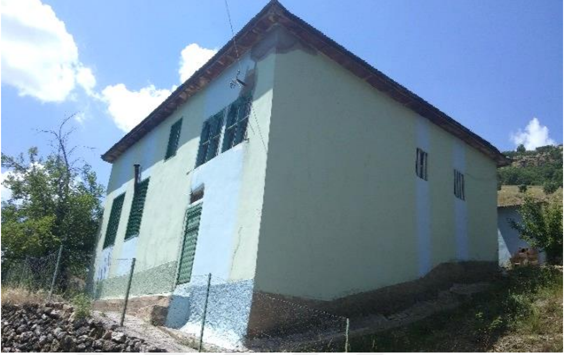
Fotoğraf 31: Cami dođu ve kuzey cepheleri- cami giriř kapısı
