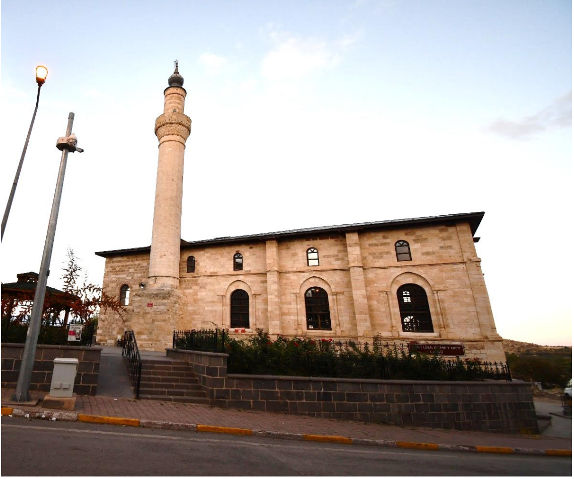
Fotoğraf 13: Cami batı cephesi
