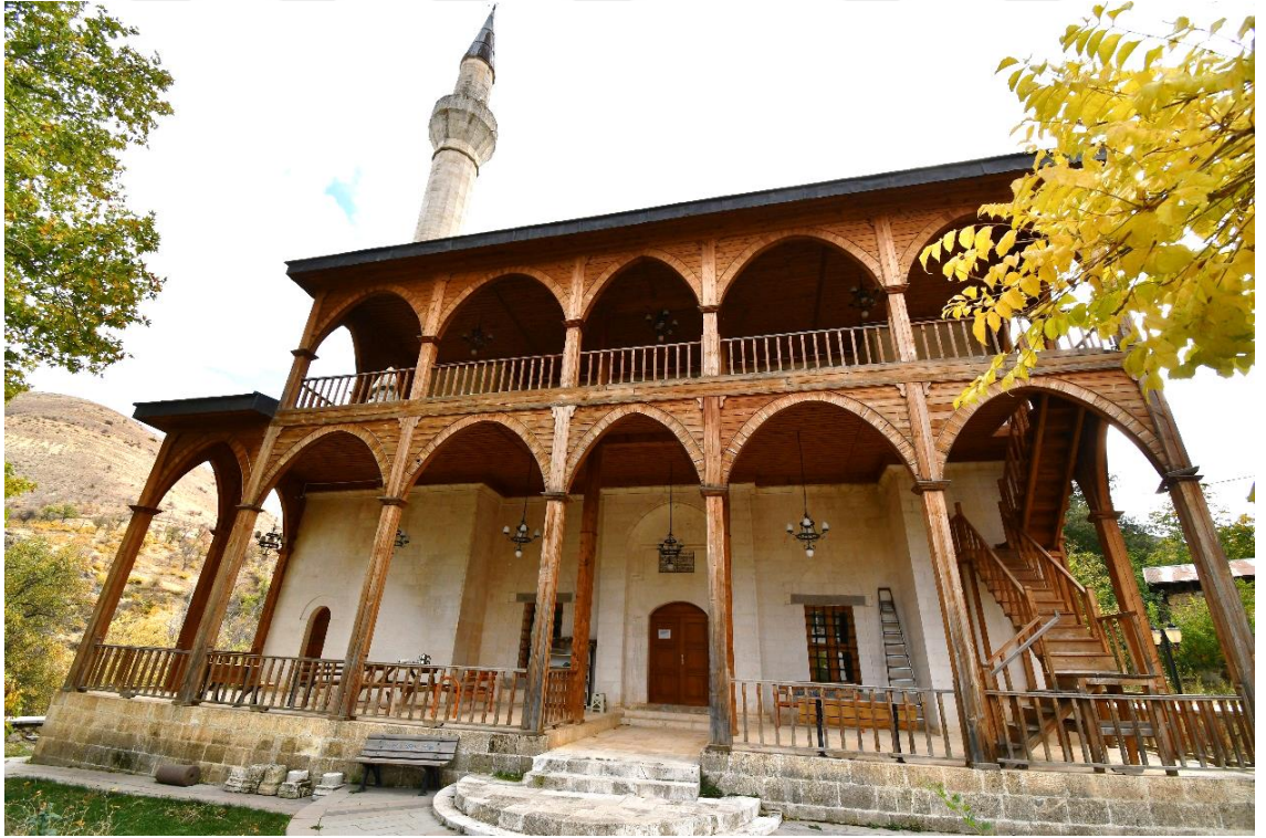
Fotoğraf 6: Cami kuzey cephe- son cemaat kısmı
