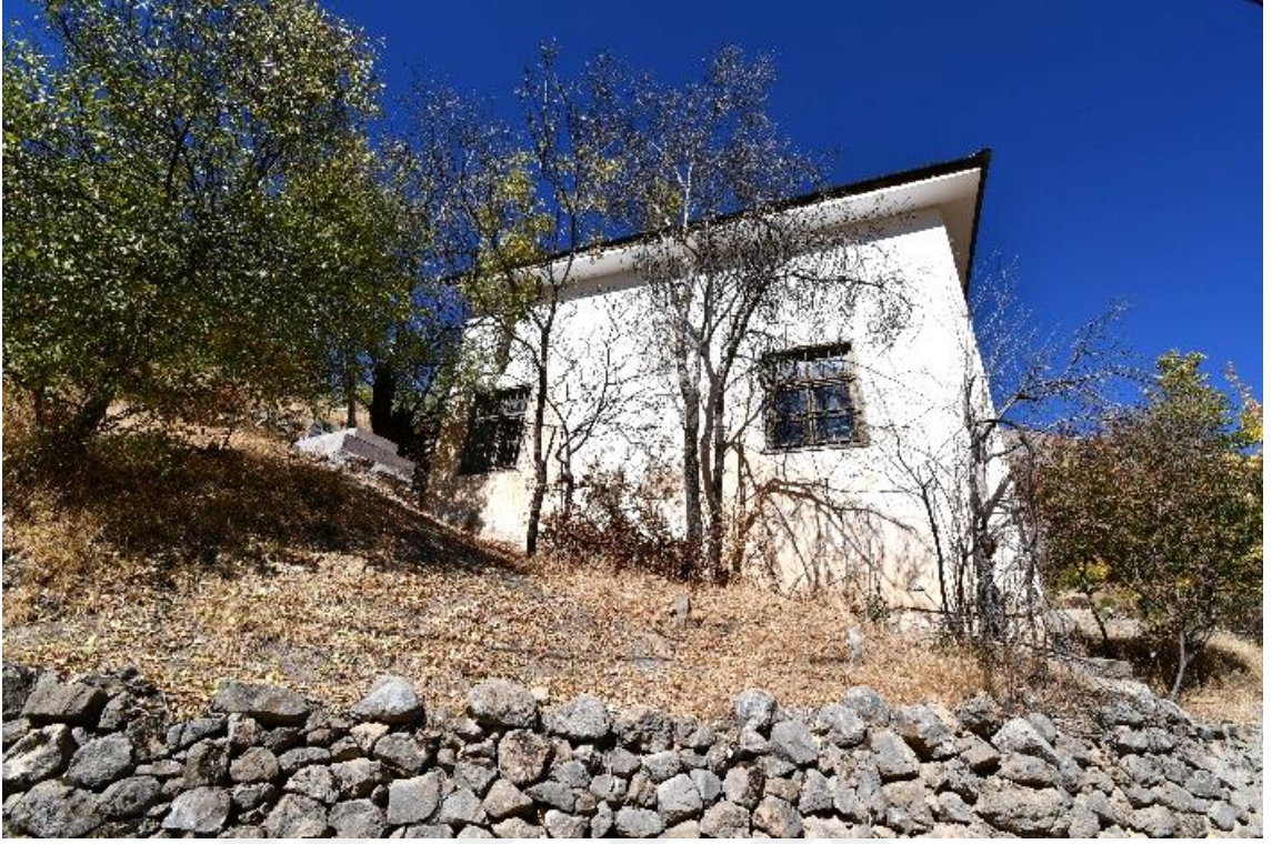
Fotoğraf 48: Cami güney cephesi
