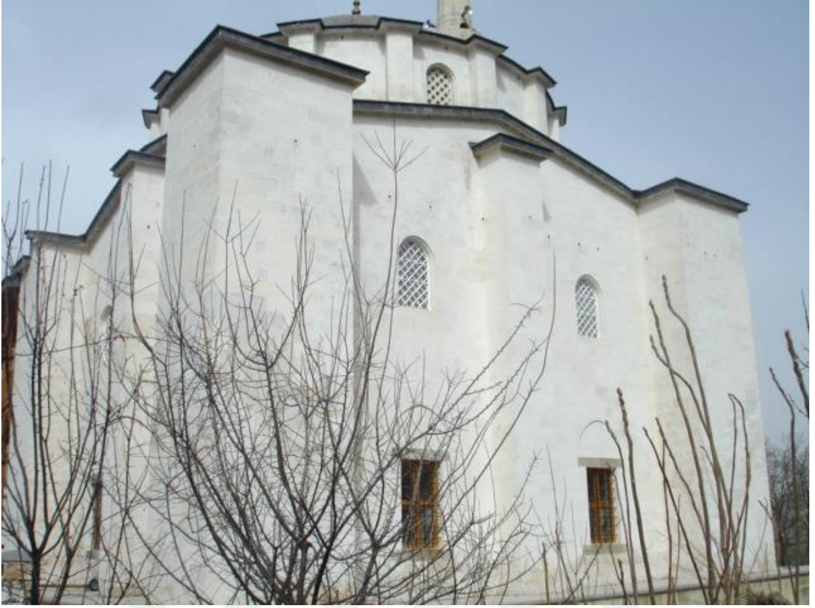
Fotoğraf 5: Cami güney cephesi
