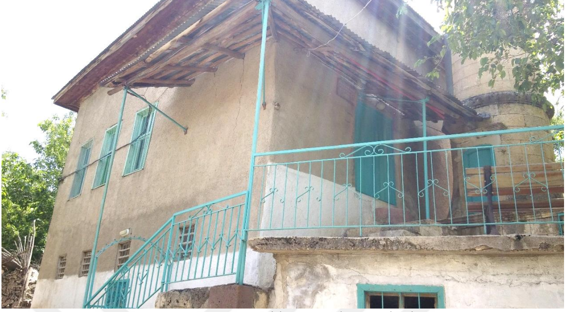
Fotoğraf 20: Cami kuzey ve batı cephesi
