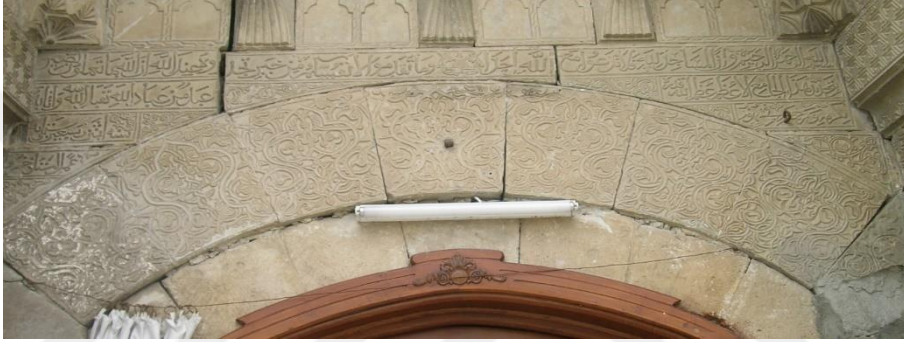
Fotoğraf 2.10. Battalgazi Ulu Camii doğu taç kapı kitabesi
