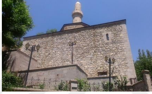
Fotoğraf 2.283. Arapgir Cafer Paşa Camii beden duvarları
