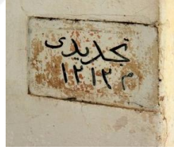
Fotoğraf 2.312. Arapgir Hacı Yahya Camii onarım tarihi
