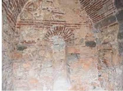
Fotoğraf 2.249. Arapgir Yeni Camii, mihrap önünü örten çapraz tonozun görünüşü
