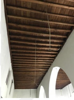
Fotoğraf 2.212. Hacı Bekir Camii ahşap üst örtü
