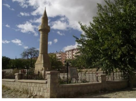
Fotoğraf 2.369. Darende Hacı Müşrif Camii minaresi kaide ve restorasyon sonrası durumu
