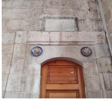
Fotoğraf 2.128. Yusuf Ziya Paşa Camii minare giriş
