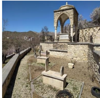
Fotoğraf 2.274. Arapgir Çobanlı Şakir Paşa Camii türbe ve hazire
