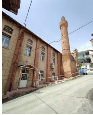
Fotoğraf 2.231. Yeşilyurt-Cami-i Kebir minaresi genel görünüm
