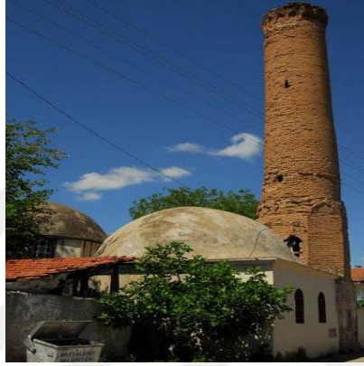
Fotoğraf 2.44. Melik Sunullah Camii onarımdan önceki minare
