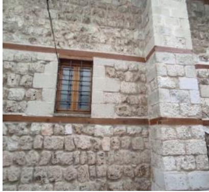
Fotoğraf 2.130. Yusuf Ziya Paşa Camii dış cephe batı duvarındaki ahşap hatıllar
