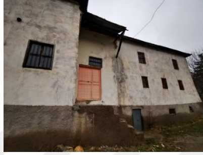
Fotoğraf 2.328. Kavasbaşı Gedelec Camii güney cephe ve cami giriş kapısı
