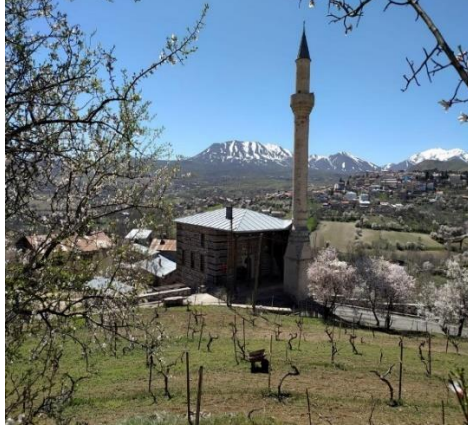
Fotoğraf 2.265. Arapgir Çobanlı Şakir Paşa Camii kuzeyden görünüm
