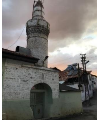
Fotoğraf 2.207. Hacı Bekir Camii avlu giriř kapısı
