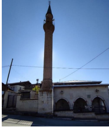
Fotoğraf 2.71. Battalgazi Karahan Camii kuzeyden görünüm
