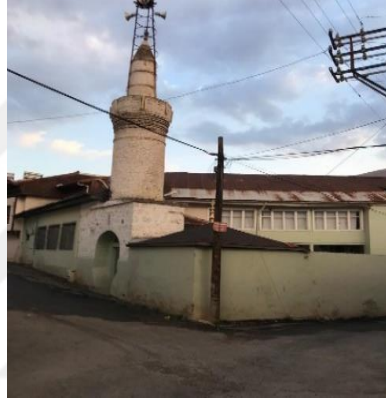
Fotoğraf 2.206. Hacı Bekir Camii genel görünüm
