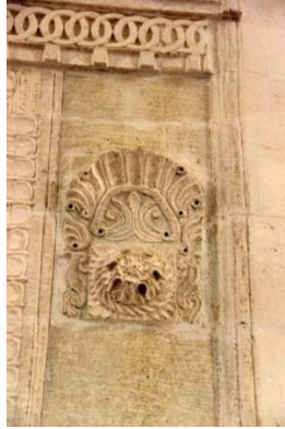
Fotoğraf 2.301. Arapgir Gümrükçü Osman Paşa Camii mihrap detay
