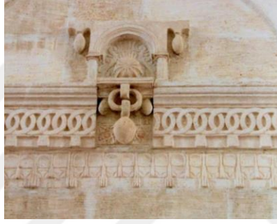
Fotoğraf 2.300. Arapgir Gümrükçü Osman Paşa Camii mihrap detay
