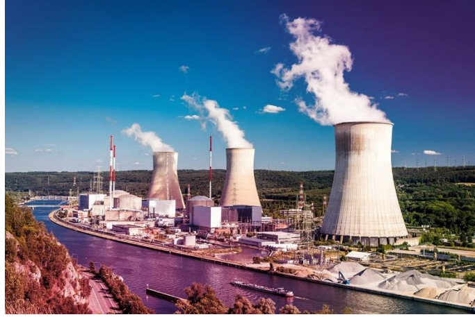
Şekil 2.2 : Nükleer enerji santrali.
