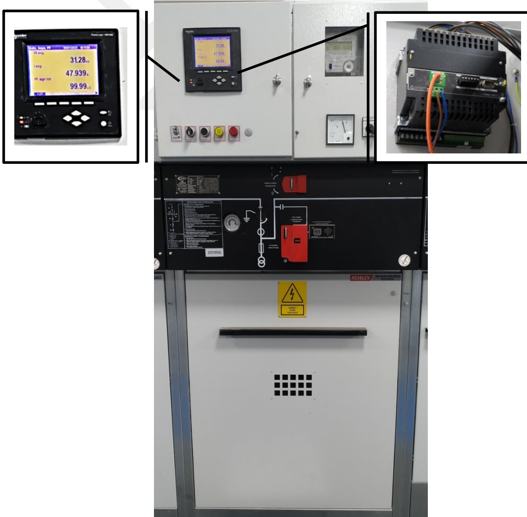
Şekil 2.5 : Akım-gerilim ölçü hücresi ve güç analizörü.
