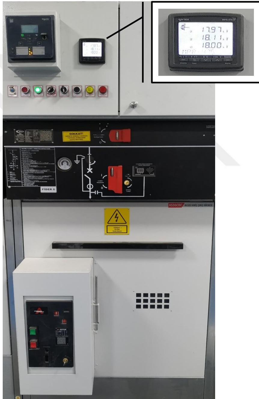
Şekil 2.3 : Enerjili kesici giriş-çıkış hücresi ve enerji analizörü.
