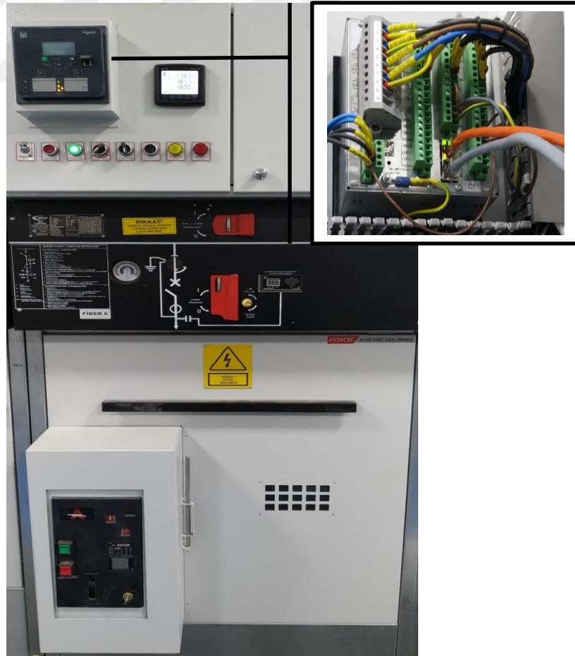
Şekil 2.4 : Enerjili kesici giriş-çıkış hücresi ve koruma rölesi.
