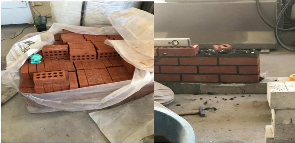
Şekil 3.9 : Standart çimentolu harçla duvar örülmesi işlemi
