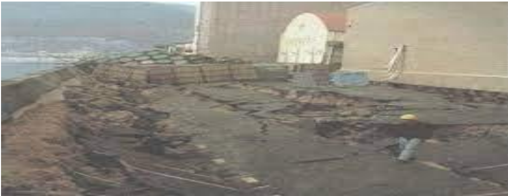
Şekil 2.7. Kobe depremi sonrasında oluşan istinat yapısı yenilmesi örneği
