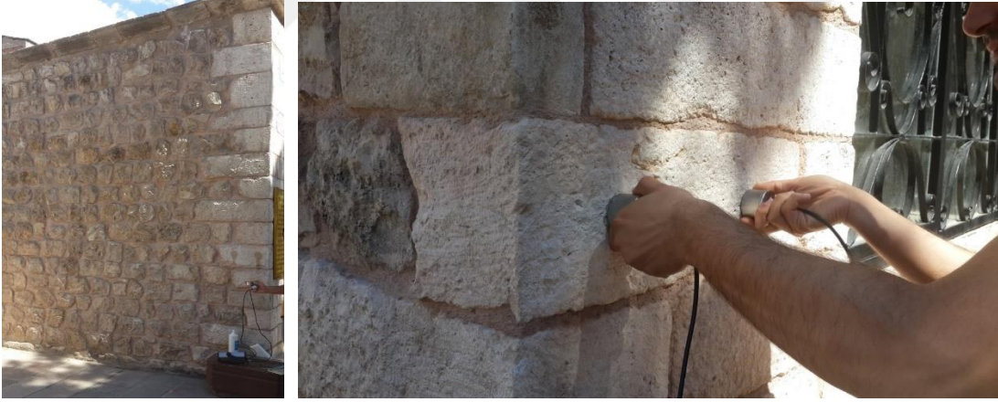
Şekil 5.3: a) Ölçüm yapılan duvar, b) UST cihazı ile ölçüm.
