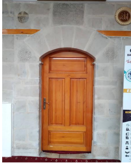
Şekil 3.5: Cami ahşap giriş kapısı
