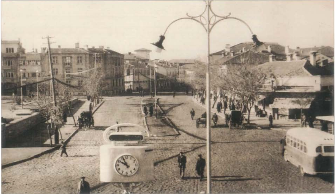
1956 yılında şehir merkezi
