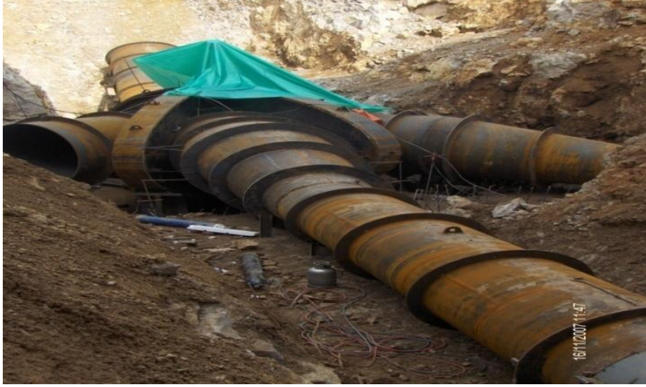
Şekil 1. Pantolon tipi bir cebri boru
