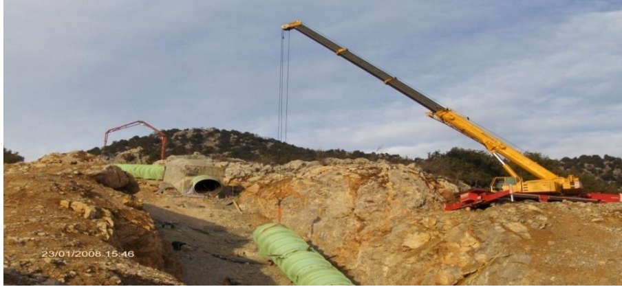
Şekil 4. Cebri boru montajı
