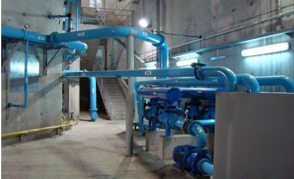
Şekil 6. Ünite soğutma sistemi
