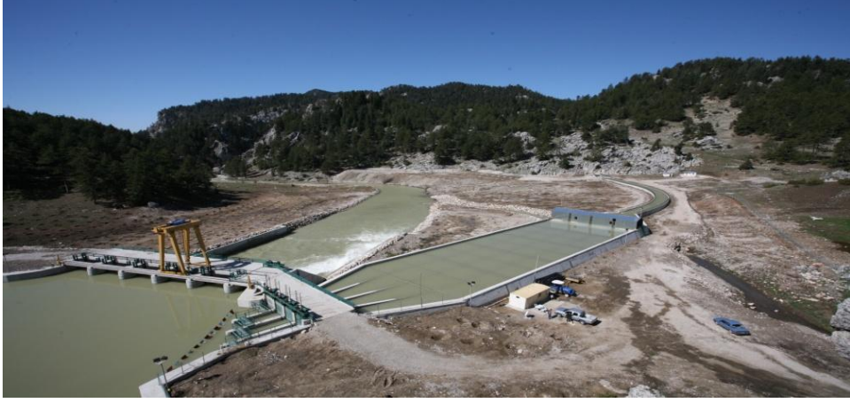
Şekil 3. Regülatör, çökeltim havuzu, açık iletim kanalı
