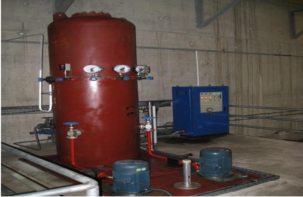
Şekil 8. Hidrolik yağ tankı
