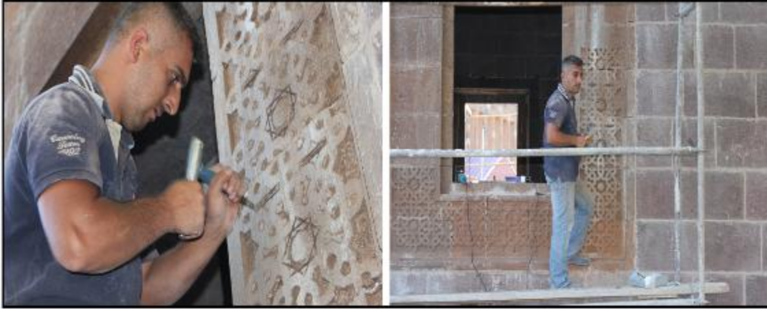
Foto 5. Hakan Usta İhlasiye Medresesi'ndeki Çalışmalarına Devam Etmektedir.
