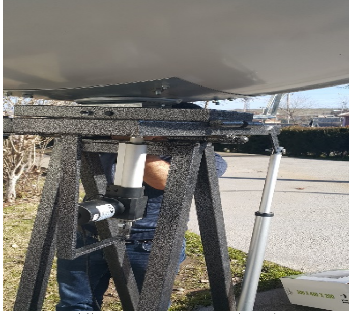
Şekil 5. SMGTS montaj çalışmaları
