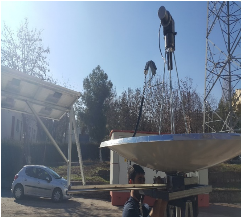
Şekil 4. SMGTS montaj çalışmaları
