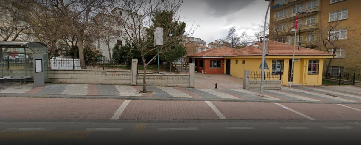
Şekil 3.8: Fırat Mahallesi Muhtarlığı (Google Sokak Görünümü)
