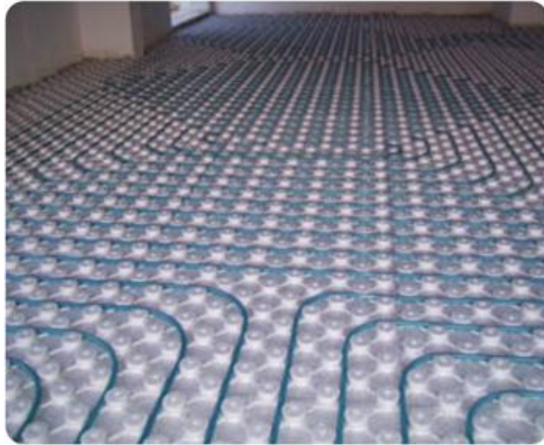
Şekil 3.3 Yerden ısıtma ve soğutma sistemi
