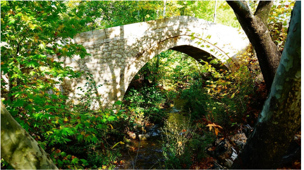
Araggir Narin Kale Köprüsü; Restora Edilmeden Önce ve Sonra (Fotoğraflar: Cumali Levent Arşivi).
