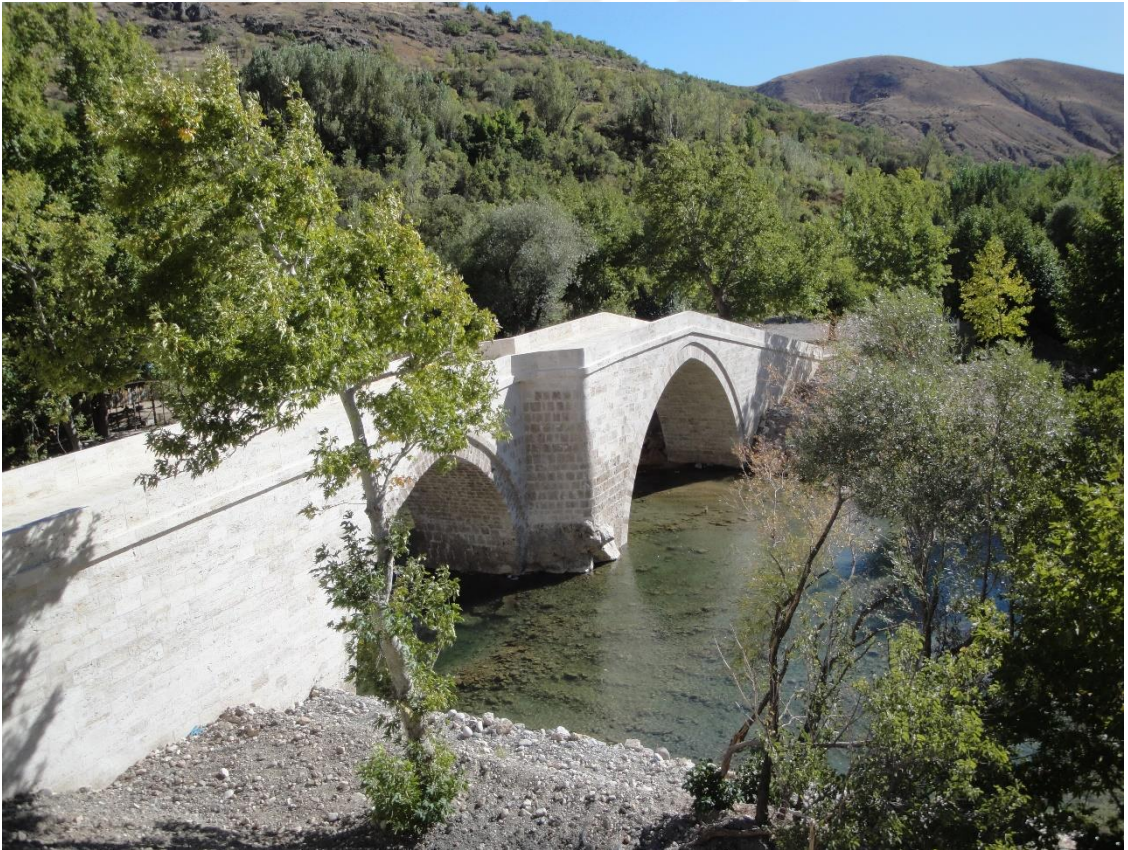
Meydan Köprüsü; köprünün onarımdan önceki ve sonraki hali (Fotoğraflar: Cumali Levent Arşivi -11 Mayıs 2011, 3 Ağustos 2011).
