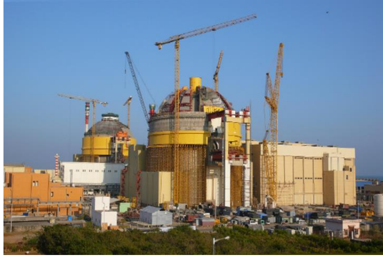
Şekil 2.5: Çelik yapı üzerine beton yapı yerleştirilmesi.
