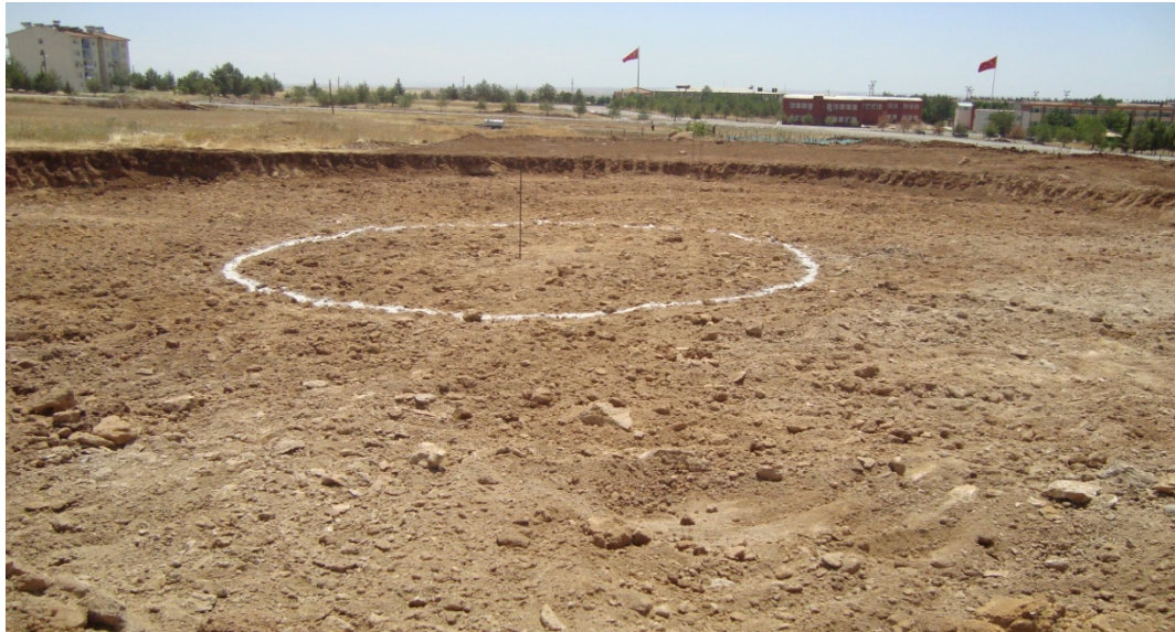
Şekil 3.10 Güneş bacası sisteminin zemin yapımını gösteren fotoğraf; toprak zemin
