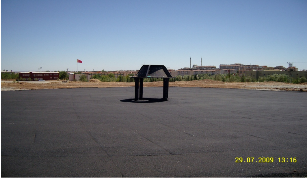
Şekil 3.15 Güneş bacası sisteminin zemin yapımını gösteren fotoğraf; asfalt zemin
