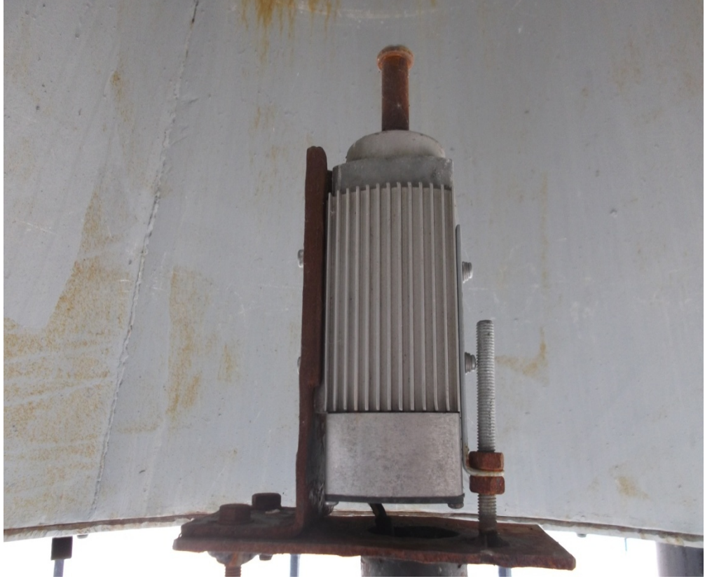
Şekil 3.26 Güneş bacası sisteminde kullanılan jeneratör
