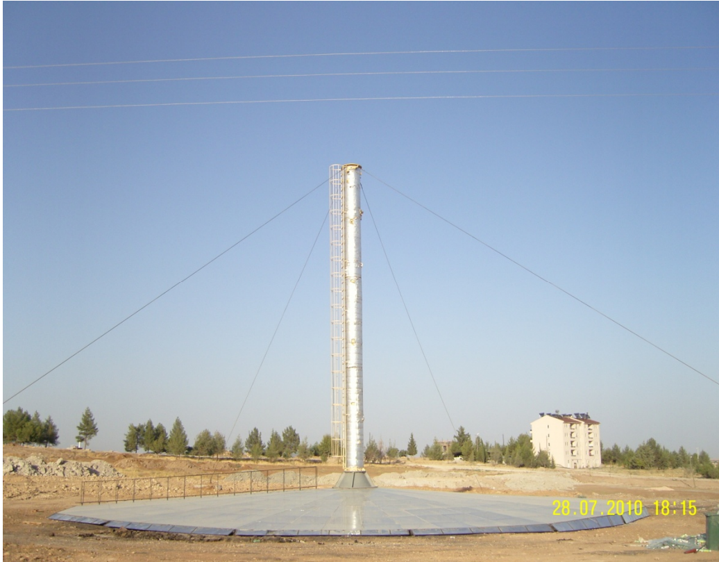
Şekil 3.28 Güneş bacası enerji santral prototipinin bitmiş hali
