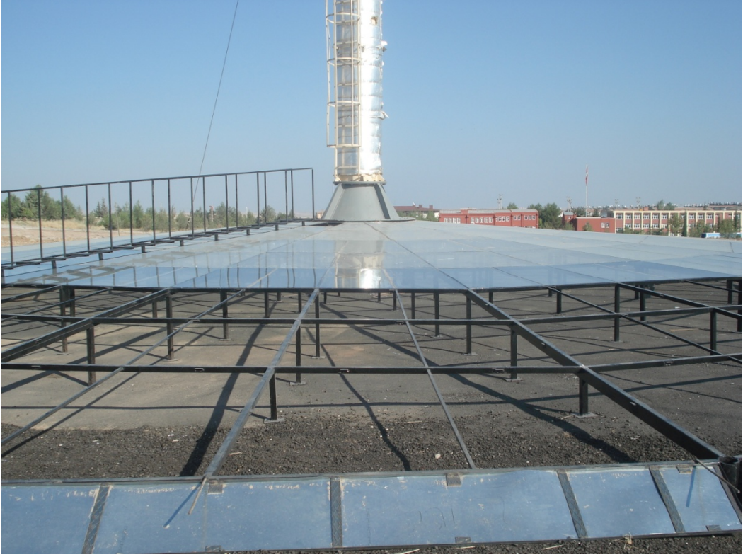
Şekil 3.21 Güneş bacası sistemi güneş kollektörünün camlarının montajı
