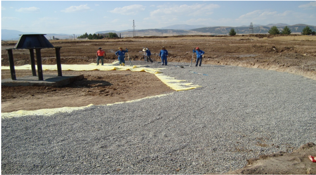
Şekil 3.12 Güneş bacası sistemin zemin yapımını gösteren fotoğraf; çakıl serilmesi
