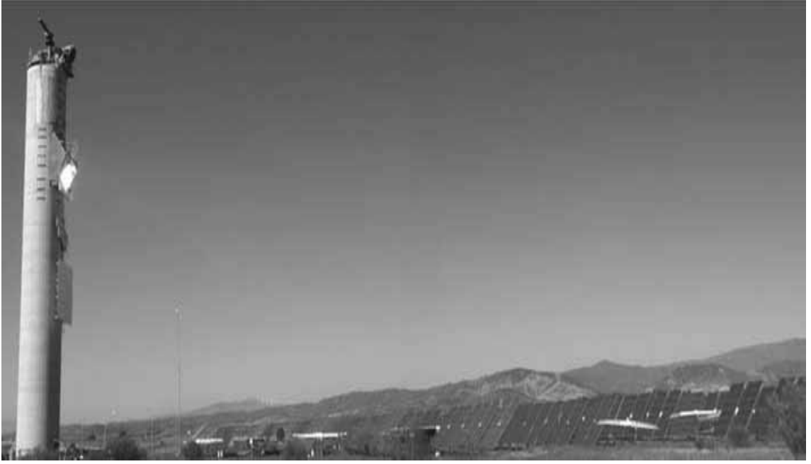
Şekil 1.2 İspanyada bulunan Güneş Termik Kule Elektrik Santrali [3]
