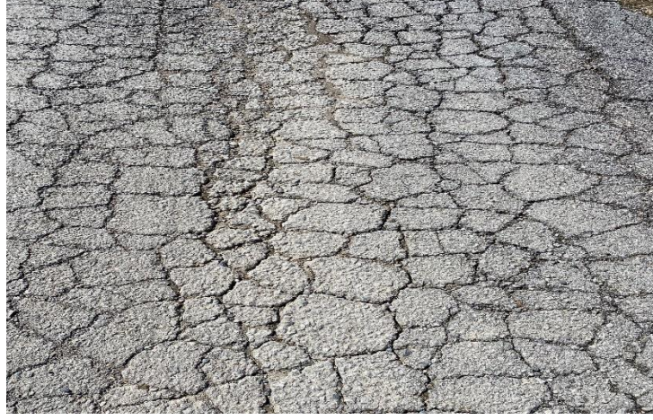
Şekil 2.36 : Yorulma çatlaklarına örnek.
