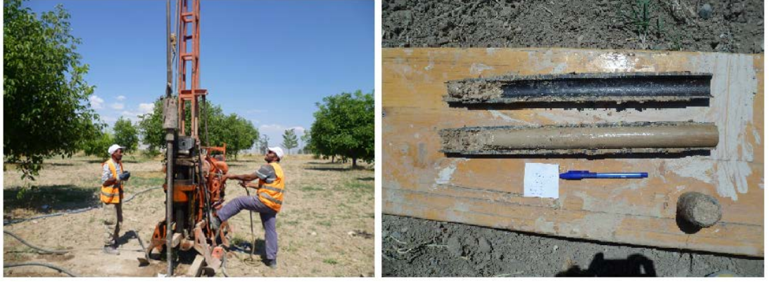
Şekil 3.7 SPT deneyi ve SPT tüpü
