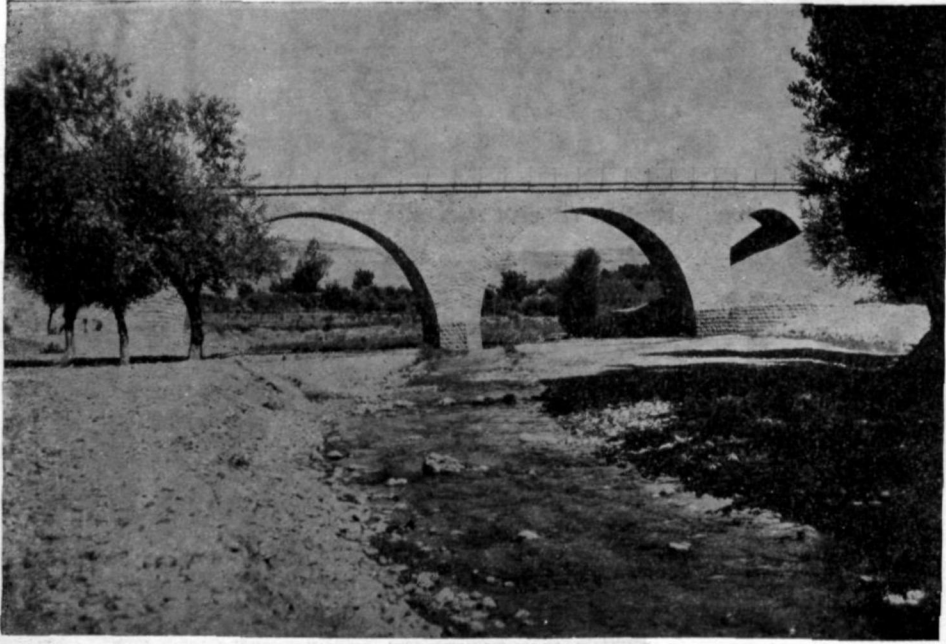
241+7 kilometrede Beydere üzerinde 8.0+2\times 18.00+8.00 açıklığında kârgir köprü Menba tarafından görünüş.
