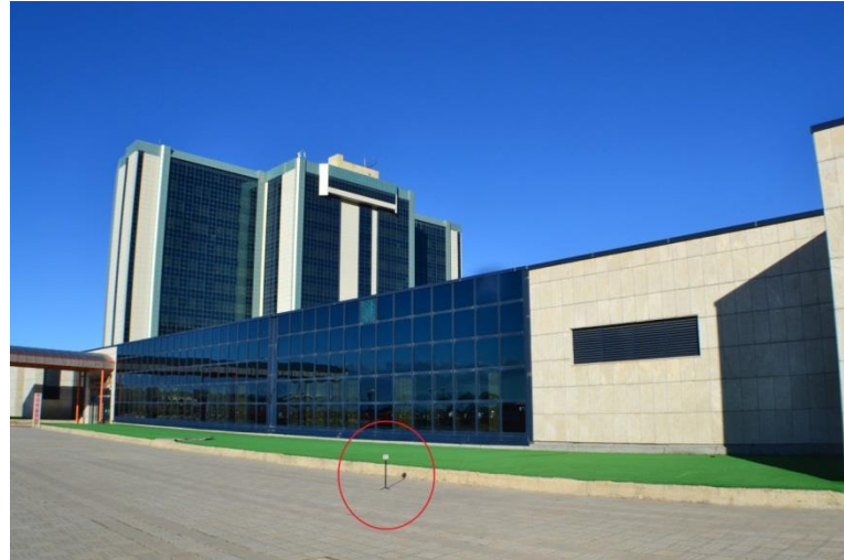
Şekil 4.39. Turgut Özal Tıp Merkezi'nin yakın bölgesinde, güç frekansında elektromanyetik alan ölçümü
