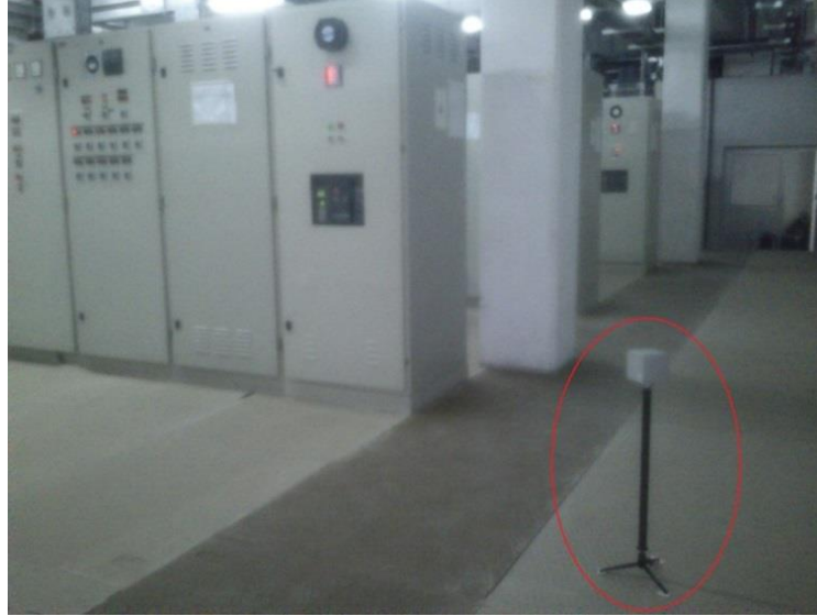
Şekil 4.42. Turgut Özal Tıp Merkezi B2 katında düşük (güç) frekansında elektromanyetik alan ölçümü
