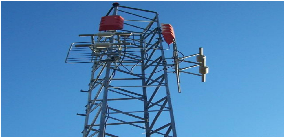
Şekil 2.12. Kathrein firmasına ait K 52 30 57 kodlu antenin saha fotoğrafı
