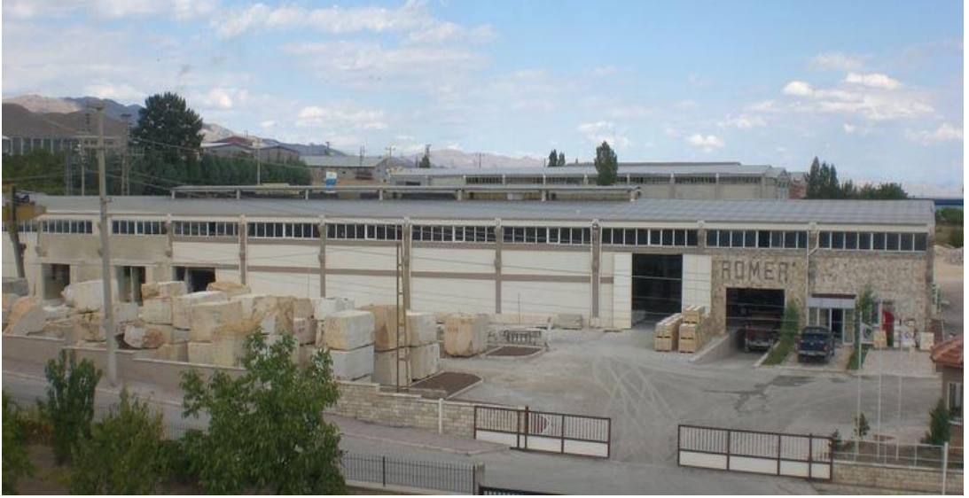
Şekil 3.1. Mermer kesim fabrikasının dıştan görüntüsü
