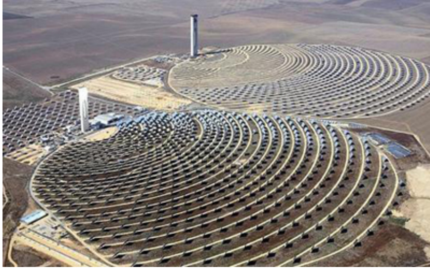
Şekil 1.10 Merkezi alıcılı güneş santrali [13]
