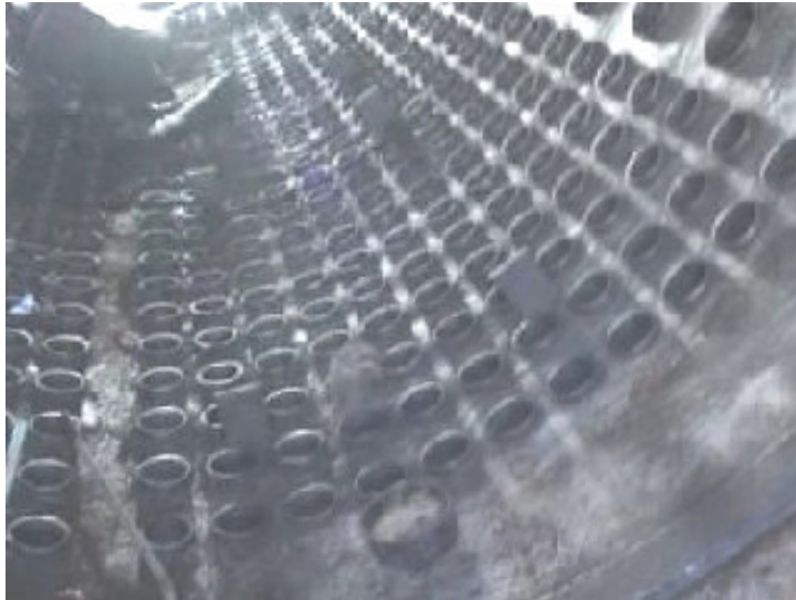
Şekil 12. Buhar domunun iç yapısı
