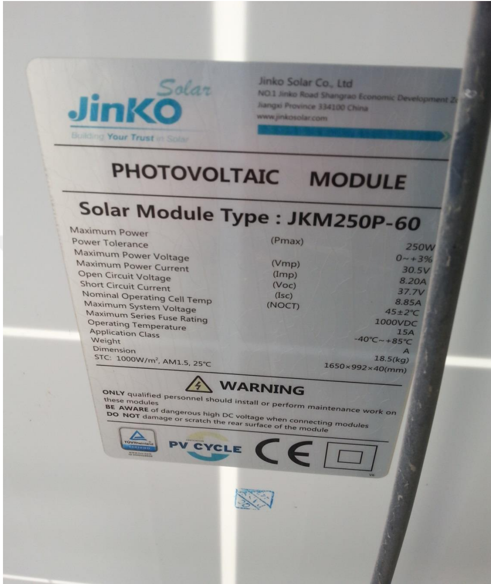
Şekil 6.3 Sistemde Kullanılan Fotovoltaik Modül Tipi ve Özellikleri
