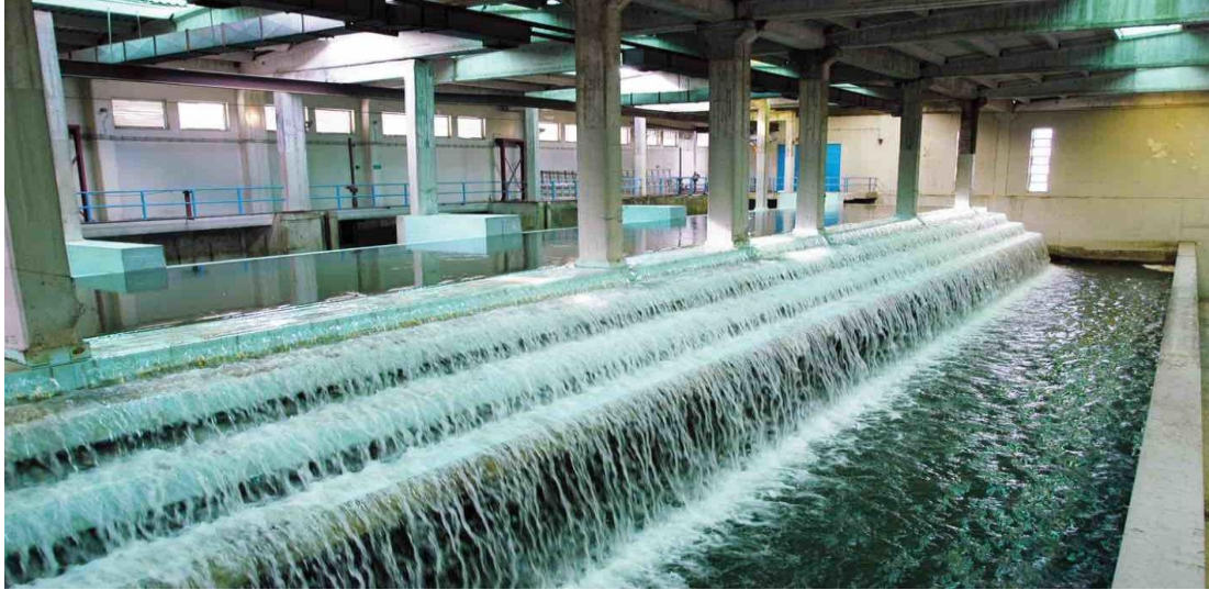
Şekil 4.3 Su arıtma tesisi
