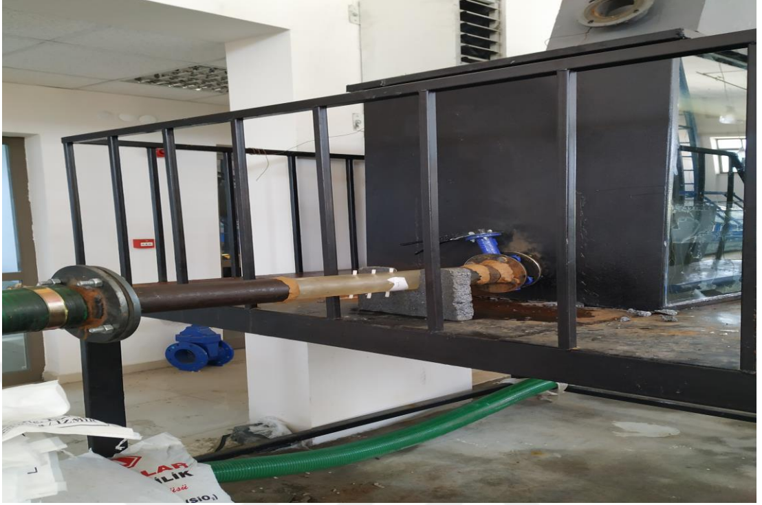
Şekil 5.9 Venturinin sistem içerisindeki bağlantısı
