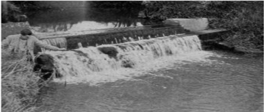
Şekil 3.3 Basamaklı savaklardaki havalandırmanın araştırılması [4]
